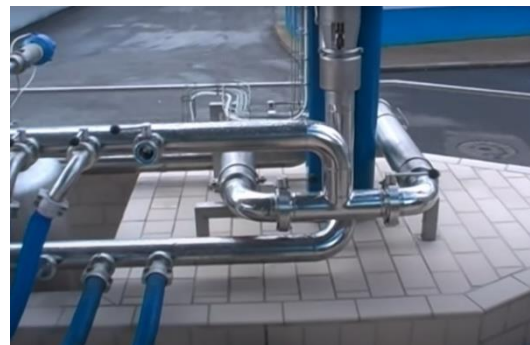
Ilustración 23: Descarga de la leche cruda y tuberías
