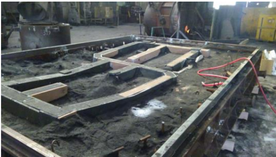
Figura 20. Llenado del sobre y colocación de canales de colada
