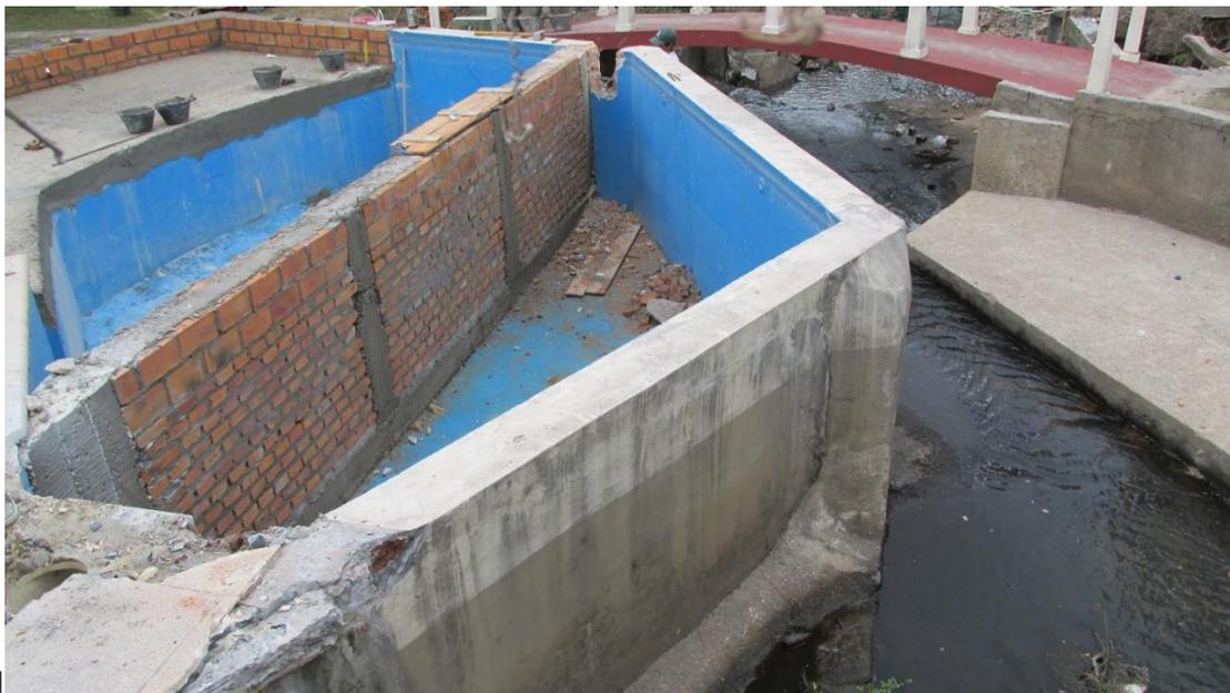
*Fotografía N°10 - Demolición de piscina en el cauce.*
