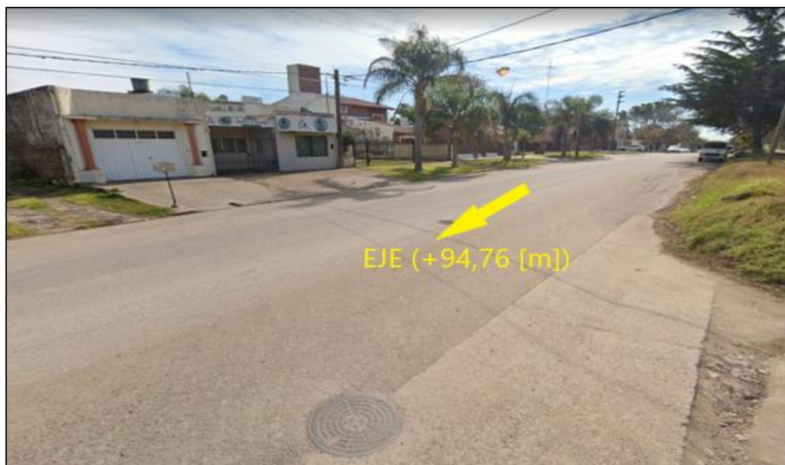
Figura 8.2 – Inicio de pavimentación en Av. Ramírez y Luis Noacco
