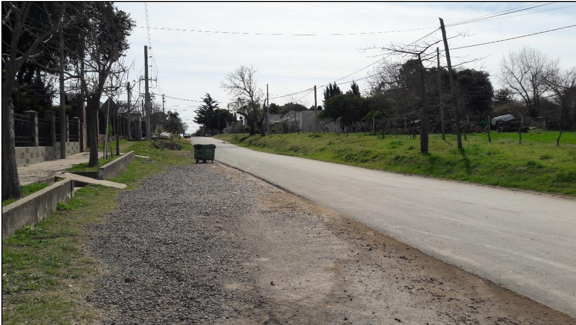
Figura 1.7 – Tramo con pavimento asfáltico de 6,00 [m] de ancho
