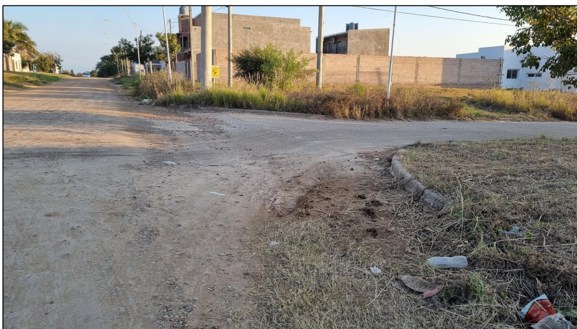
Figura 4.36 – Badén existente en esquina de Av. Ramírez y Crisólogo Larralde (lado oeste)
