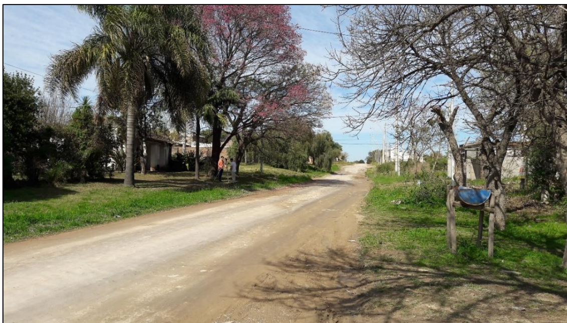
Figura 4.9 – Tramo entre zona baja y calle Facundo Cabral
