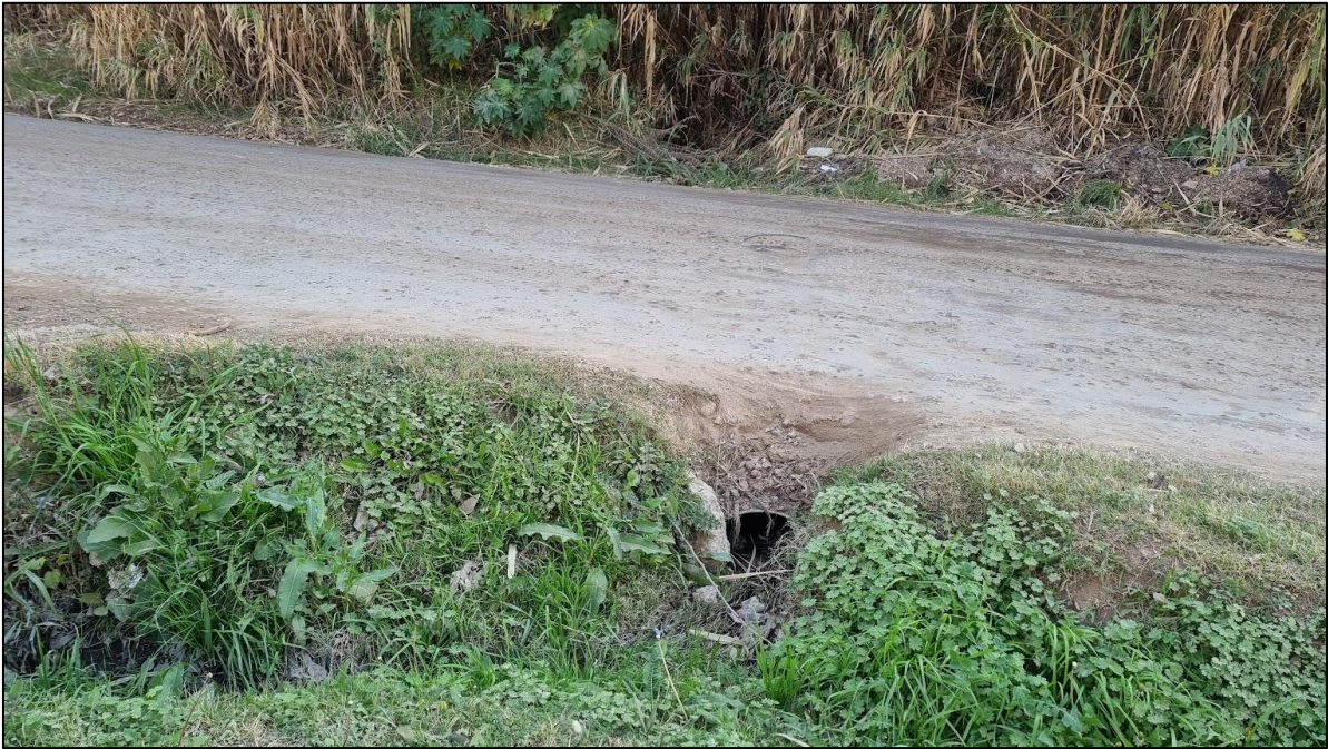
Figura 4.37 – Conducto existente en zona baja
