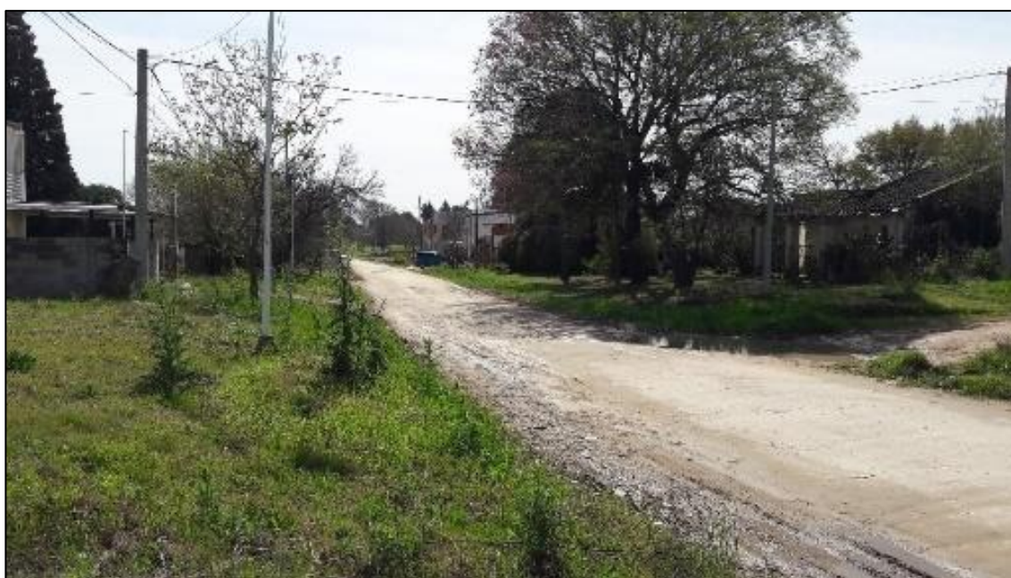
Figura 1.6 – Tramo sin pavimento asfáltico
