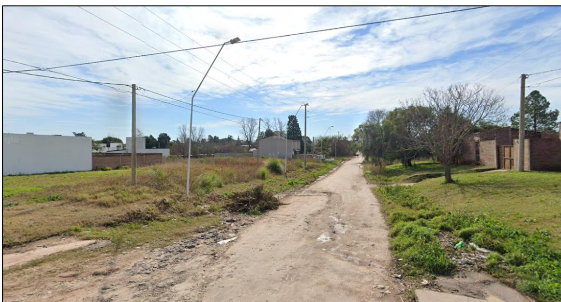
Figura 4.26 – Columnas de alumbrado público
