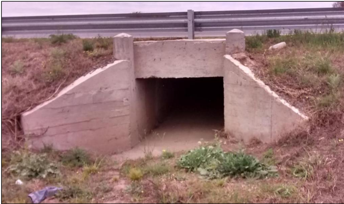
Figura 8.4 – Alcantarilla tipo cajón
