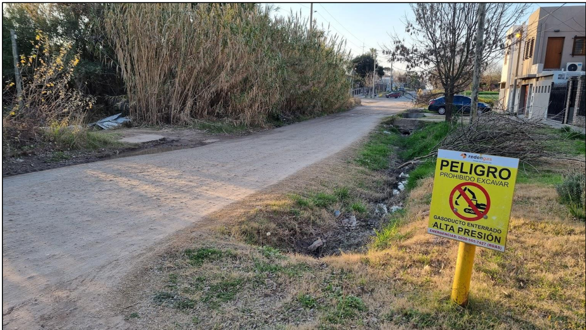
Figura 4.25 – Cartel de advertencia de gasoducto de alta presión (zona baja)
