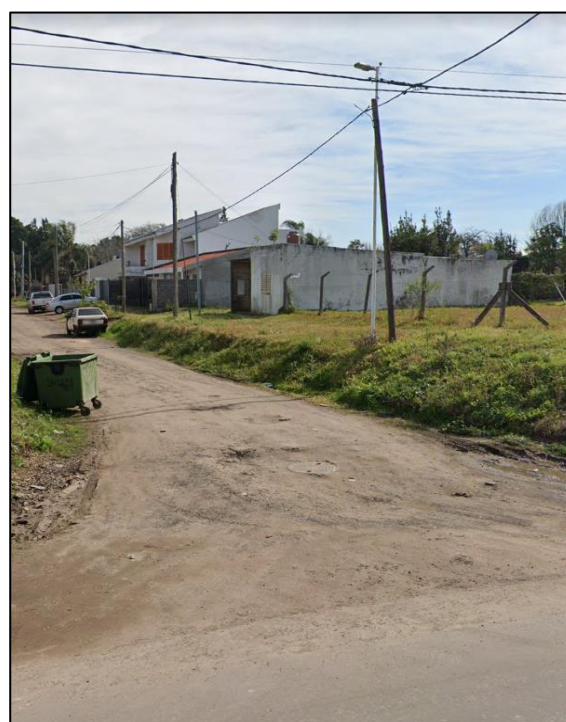
Figura 4.24 – Boca de registro cloacal en Av. Ramírez y Telemaco Susini
