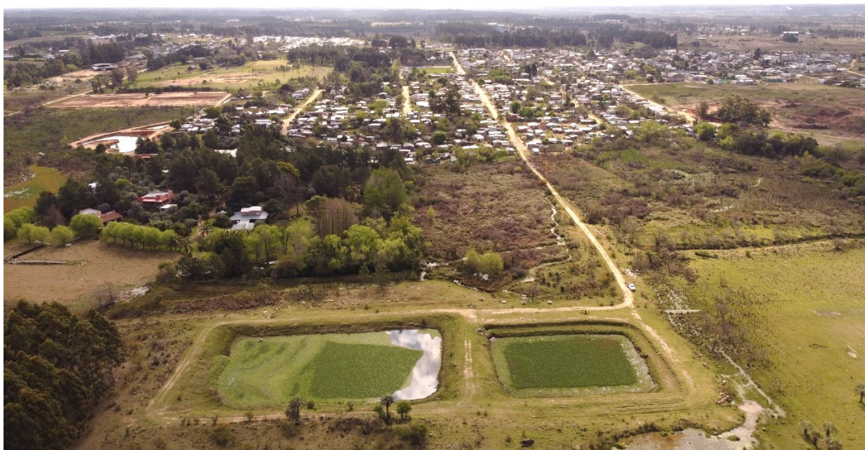
Figura 1. Piletas de tratamiento de aguas residuales
