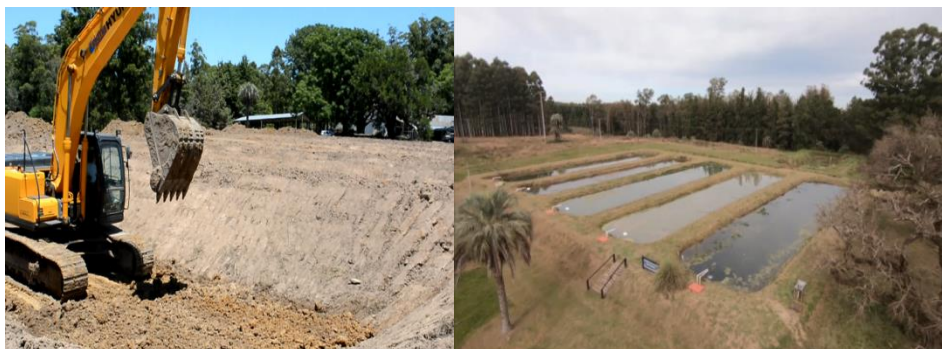
Fig.4: a) retroexcavadora construyendo los estanques en la EASG, b) vista aérea de los 5 estanques de producción de la EASG
