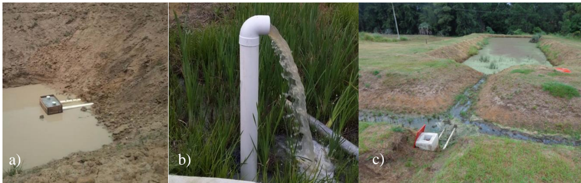
Fig. 2: a) Desagüe previo al llenado de los estanques, b) desagüe elevado para la toma muestra del efluente y c) zanja colectora de los desagües de los estanques y estanque de recuperación de nutrientes.
