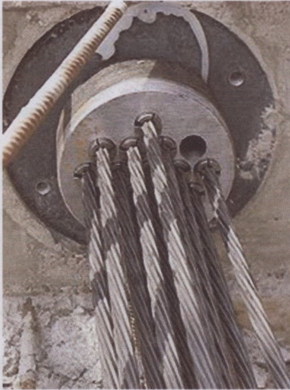
Figura 2: Placa de anclaje de los cables de pos-tensado en un puente.
