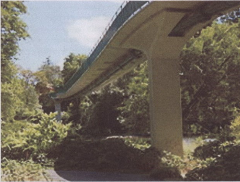
Figura 1: Puente peatonal en volados sucesivos pos-tensados, Grants Pass, Oregón, EEUU
