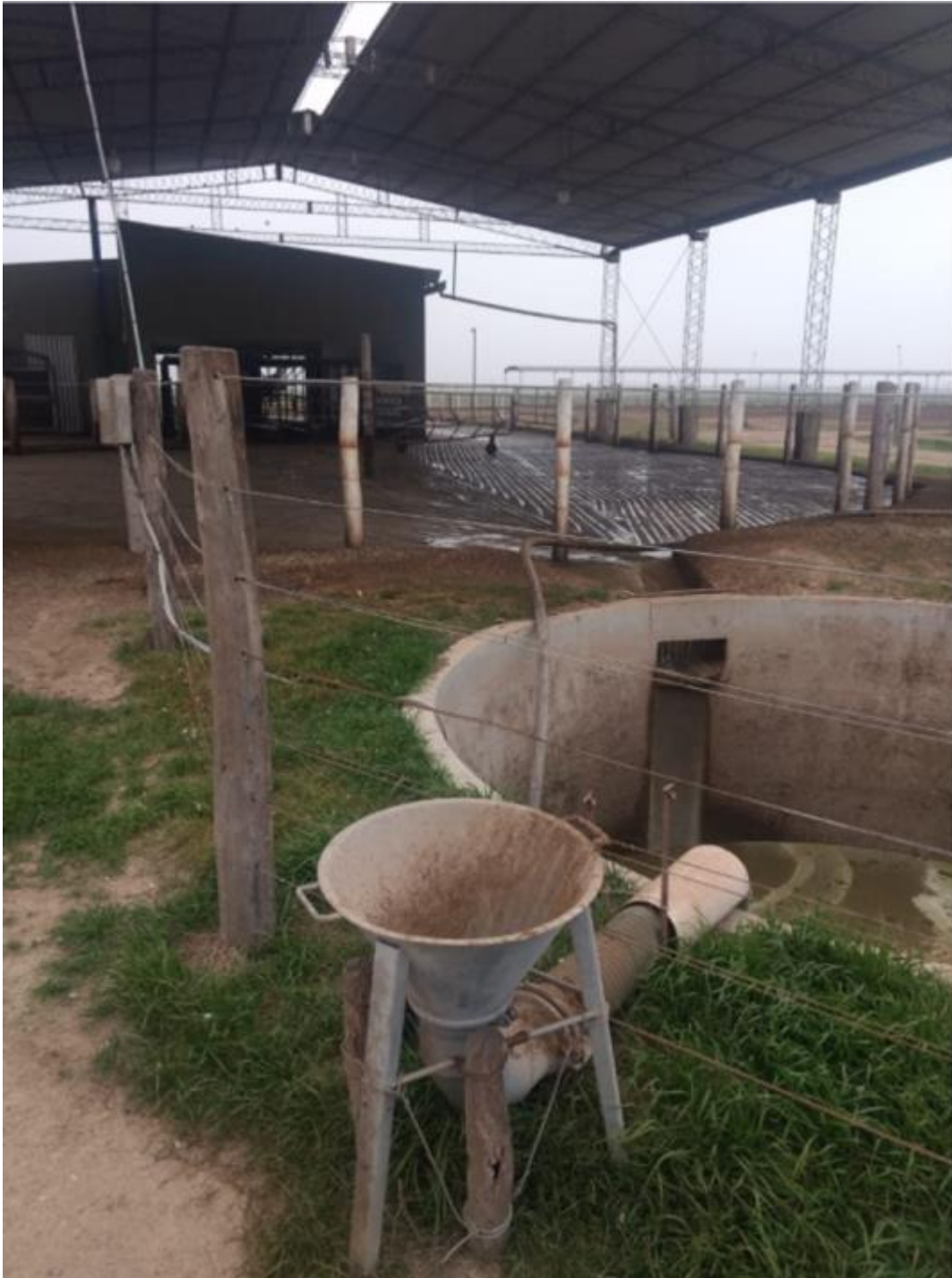
Figura N°10. Sistema de efluentes
