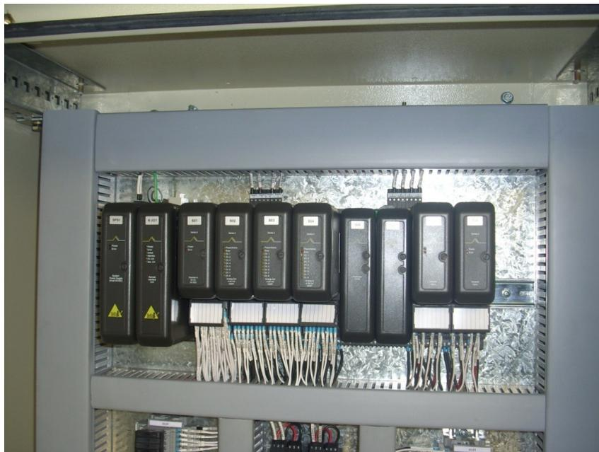
Figura 40: Tableros de los remote I/O
