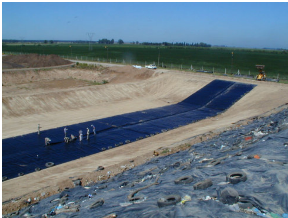
Se observa la colocación de membrana en un sector y los residuos del sector adyacente cubiertos por una cobertura sintética en vez de tierra.
