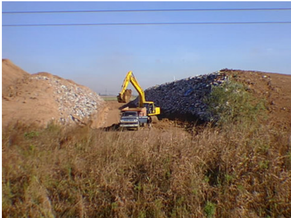
Excavación de una trinchera (sin impermeabilización de fondo), enterramiento controlado.
