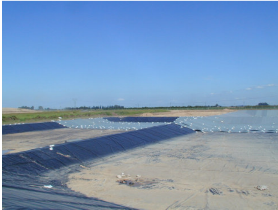
Dos sectores impermeabilizados donde se está colocando un geotextil de protección de membrana
