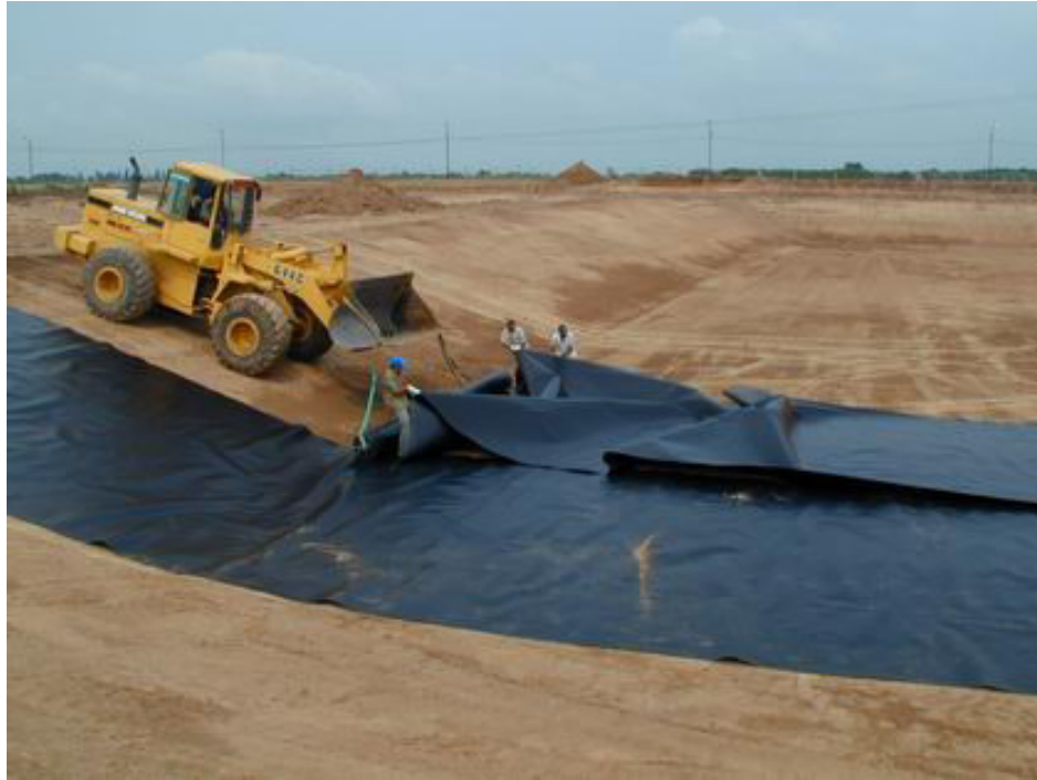
Colocación de membrana de PAD
