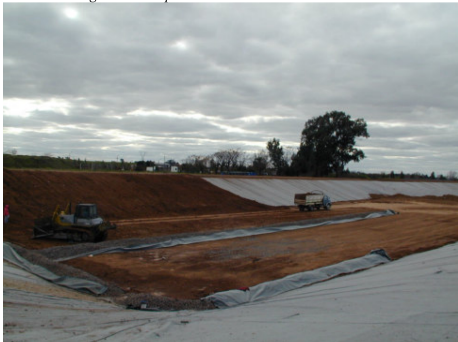
Colocación del suelo de cobertura de membrana
