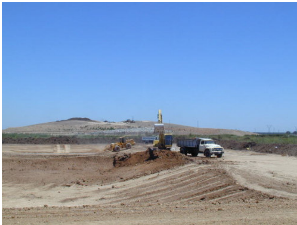
Excavación de dos sectores
