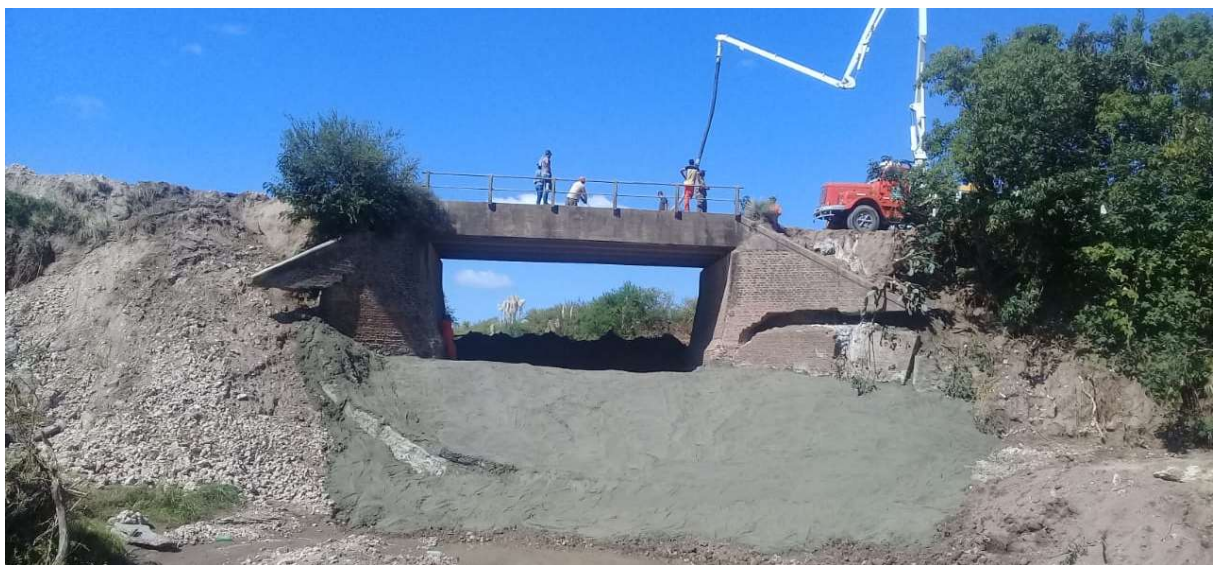
Figura 1. 6. Reparación realizada en Marzo 2019
