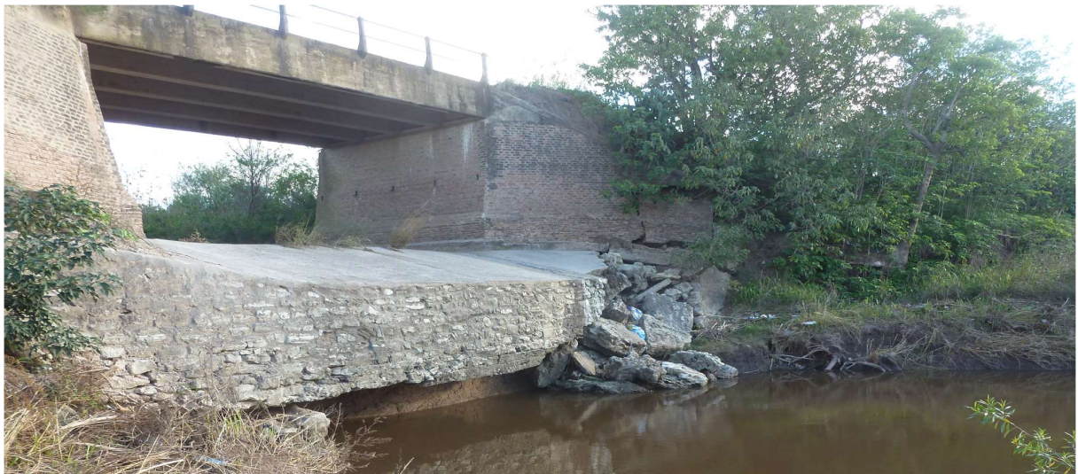
Figura 1. 4. Platea de escurrimiento y muro de ala izquierdo aguas abajo
