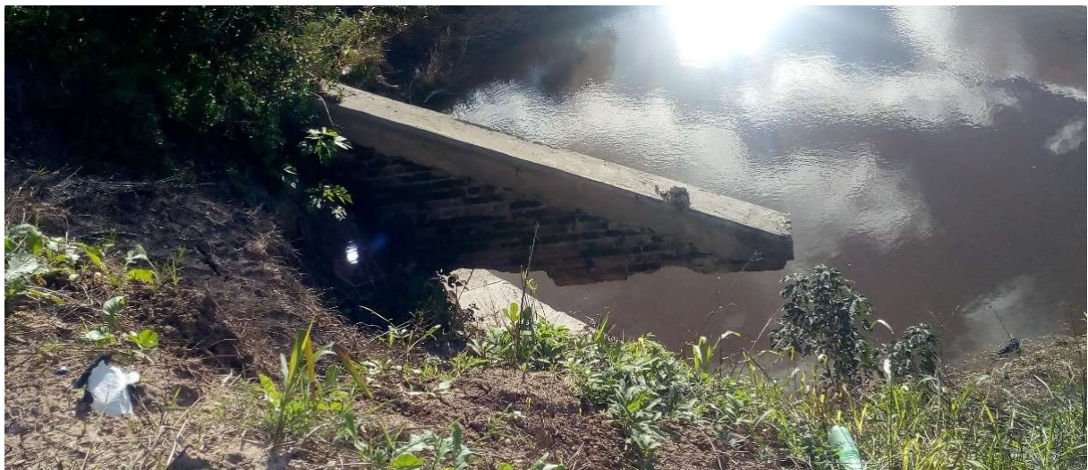
Figura 1. 3. Muro del ala derecho aguas abajo
