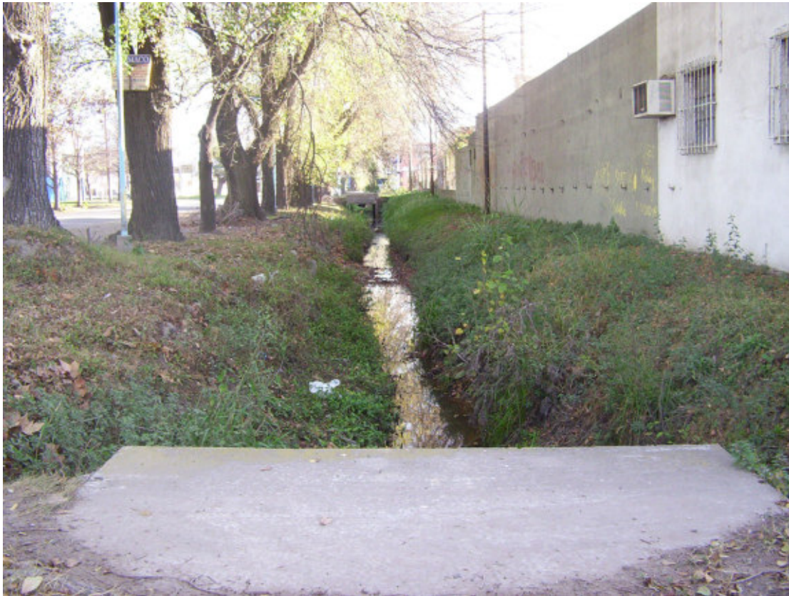
Figura 5.1: Estado actual del canal en calle Jorge Newbery.
