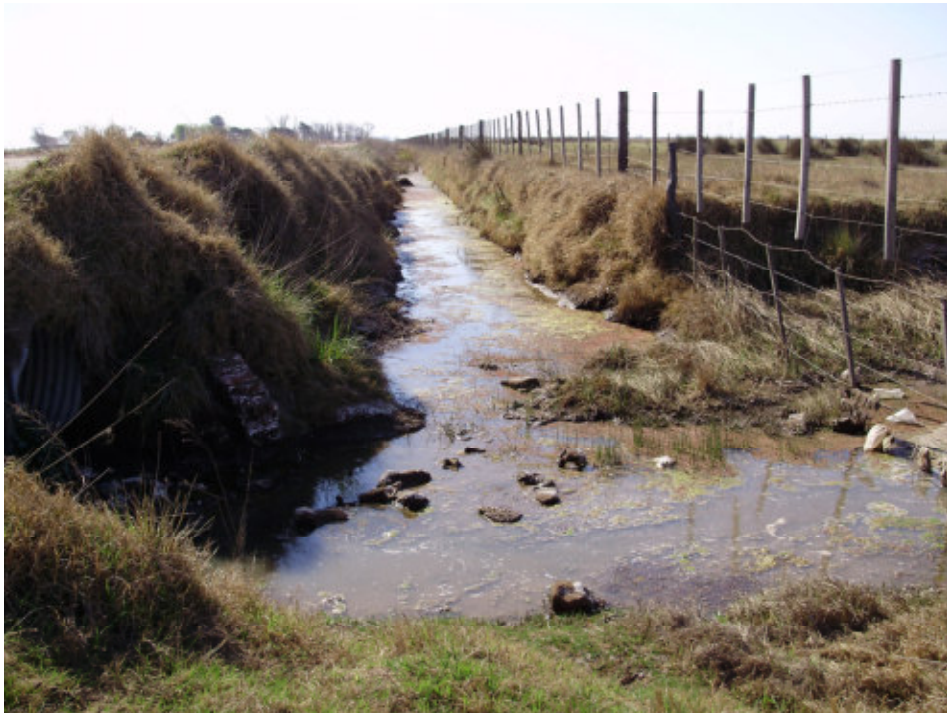
Imagen: Alcantarilla y canal hacia bajos de Cremería
