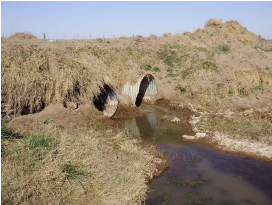
Imagen: Alcantarillas en bajos de Cremería
