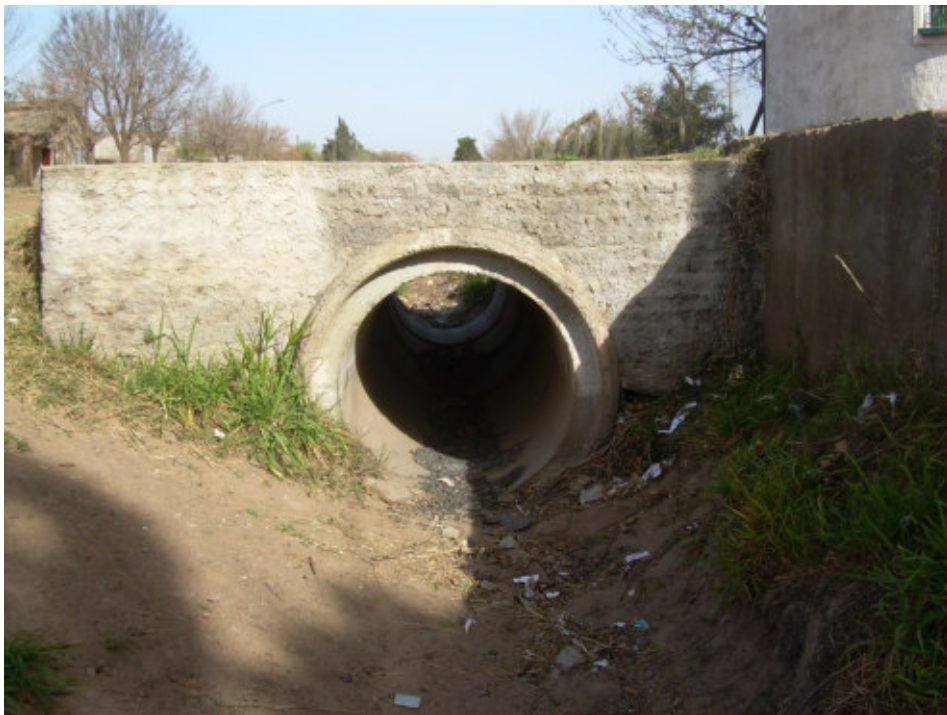
Imagen: Canal y alcantarilla Av. Libertad
