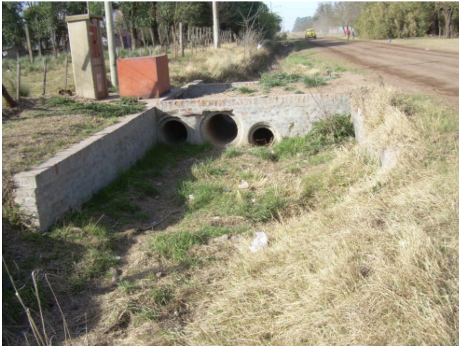
Imagen: Alcantarilla y canal calle J. J. Paso
