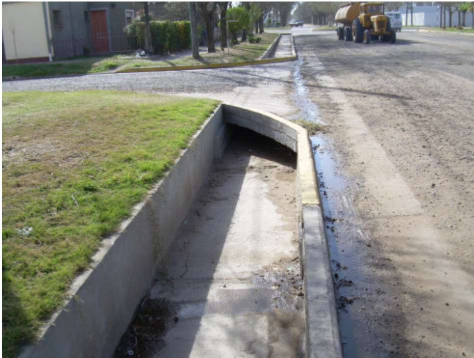
Imagen: Emisario Av. Libertad
