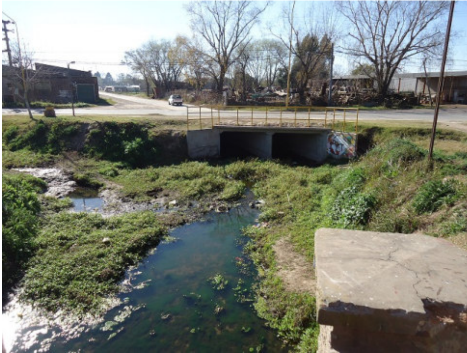
Figura 16. Encuentro canal a cielo abierto con canal entubado.- (Blas Parera)
