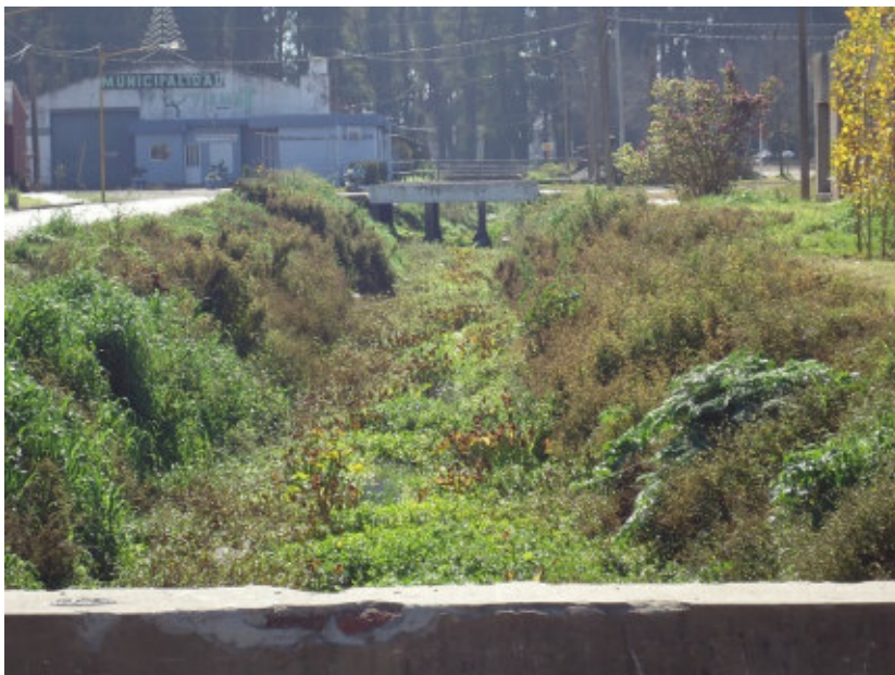
Figura 15. Canal a cielo abierto en zona urbana.-
