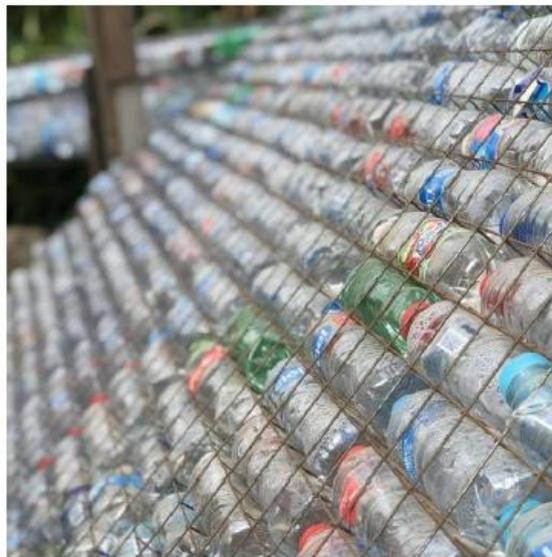
Figura N°48. Muro de botellas con bastidor metálico utilizando el lado menor.
