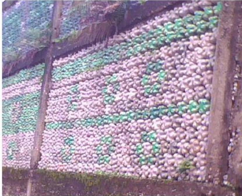
Figura N°49. Muro de botellas a hueso (sin mortero entre juntas).
