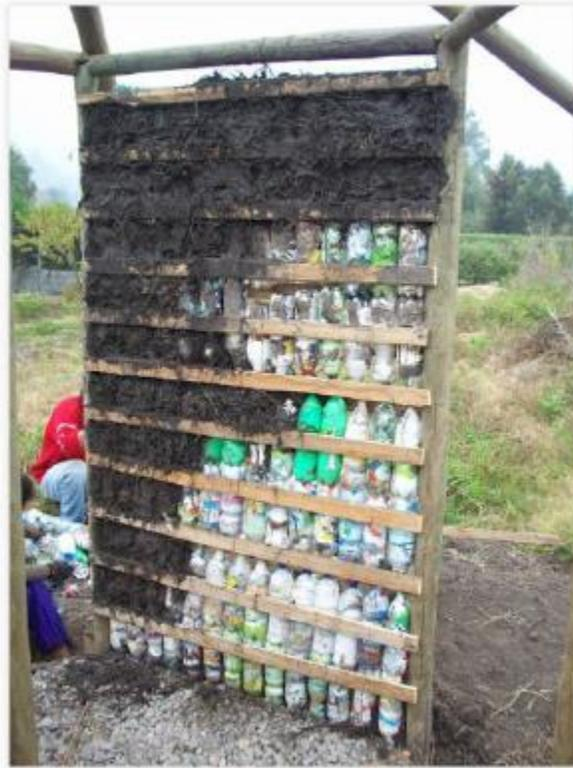
Figura N°47. Muro de botellas con bastidor de madera.
