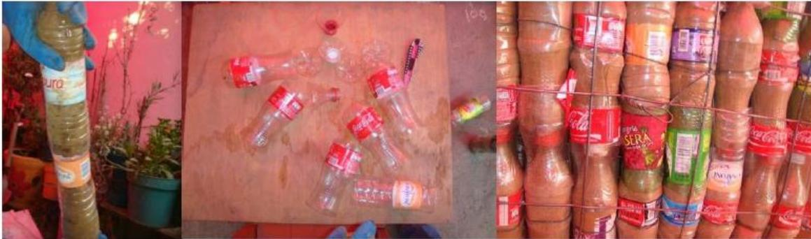
Figura N°41. Unión vertical de botellas (izq). Elementos de refuerzo (centro). Confinamiento vertical dentro de malla de acero (der).
