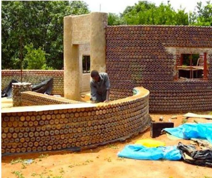
Figura 16. Casa construida con botellas de plástico PET de plástico PET
