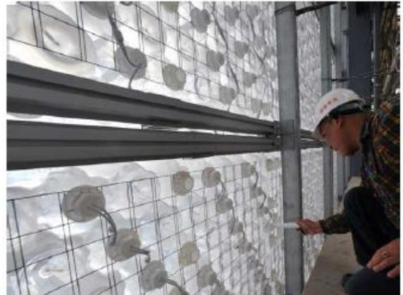
Figura 14. Sistema de conexión LED entre los Polli-brick.
