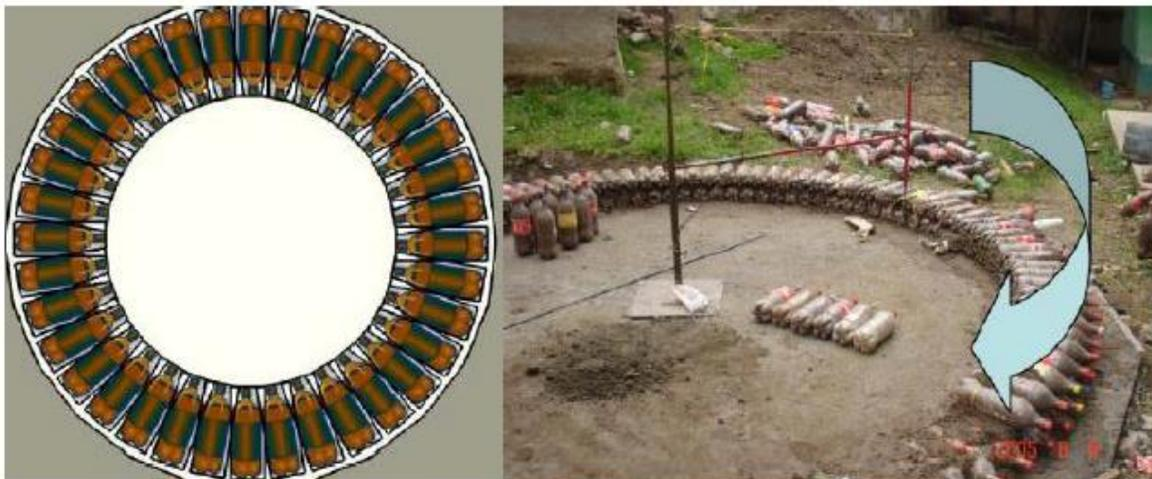
Figura N°53. Geometría sinusoidal para muros de botellas.
