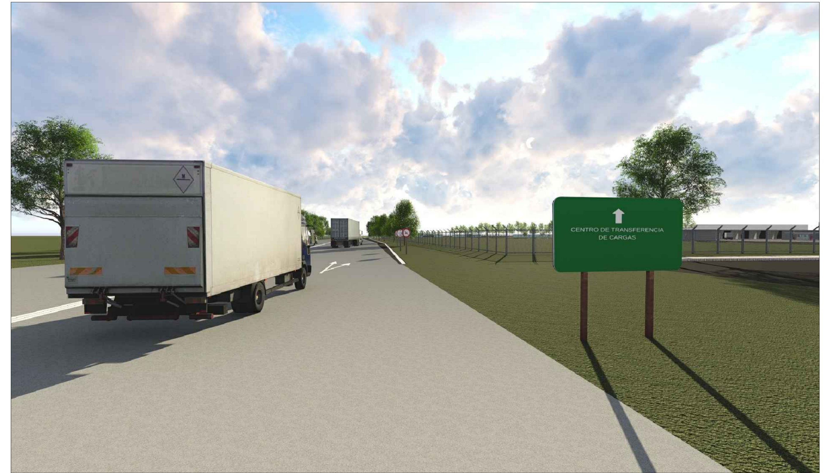
INGRESO POR RUTA PROVINCIAL N°39
