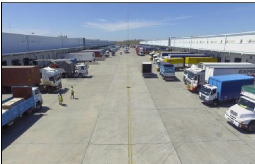
Figura 54. Instalaciones CTC. Fuente: https://www.ctcadministradora.com.ar/
