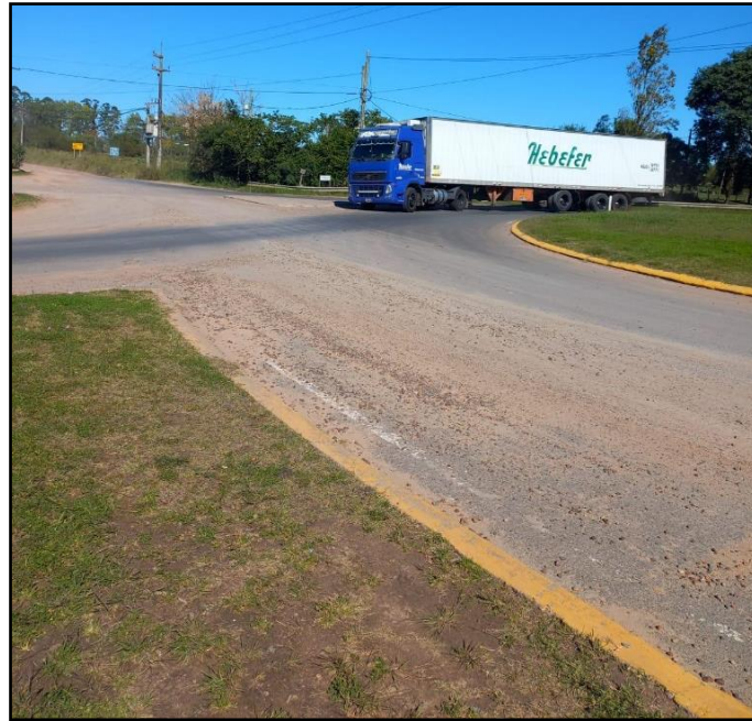
Figura 85. Parte del cordón cuneta y terreno dañado. Fuente: Propia.
