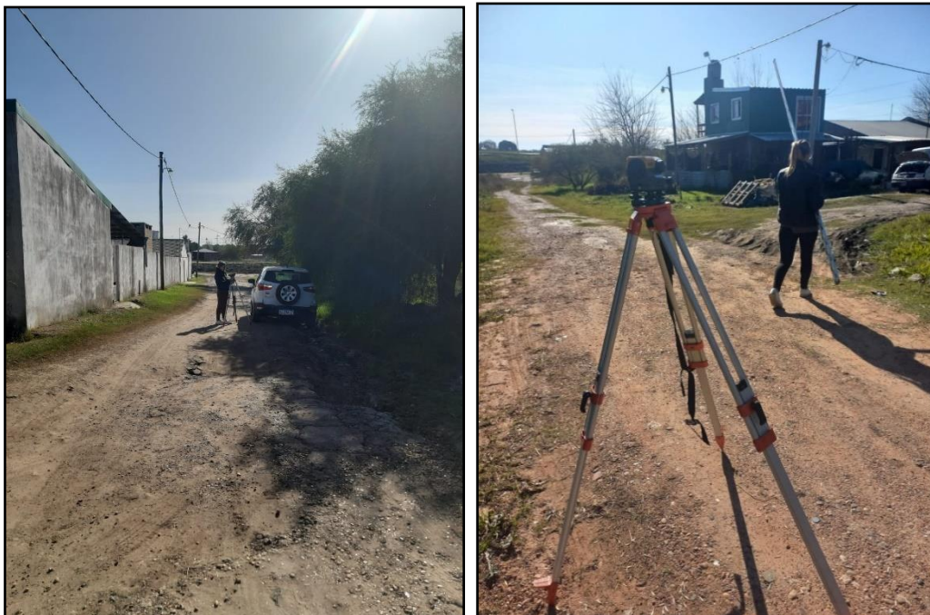
Figura 74. A la izquierda relevamiento sobre Calle Pública 1106. A la derecha relevamiento sobre Calle Pública 1102. Fuente: Propia.
