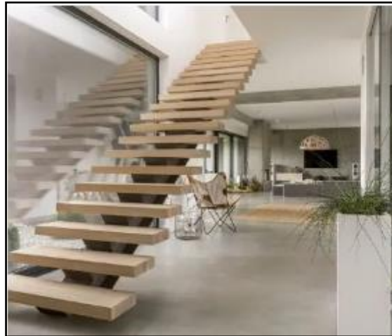
Figura 221. Escaleras voladas de madera. Fuente: https://www.maderea.es/
