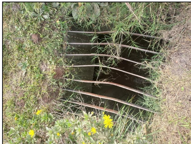
Figura 65. Rejillas sobre rotonda. Fuente: Propia.
