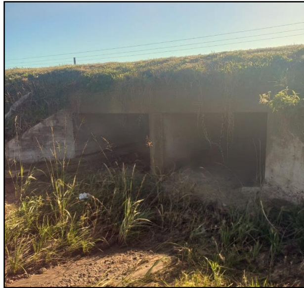
Figura 133. Alcantarilla existente sobre RPN°39. Fuente: Propia.
