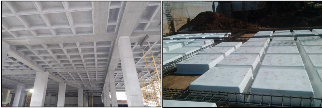
Figura 196. . Losa casetonada. Fuente: Leal todo fibras.
