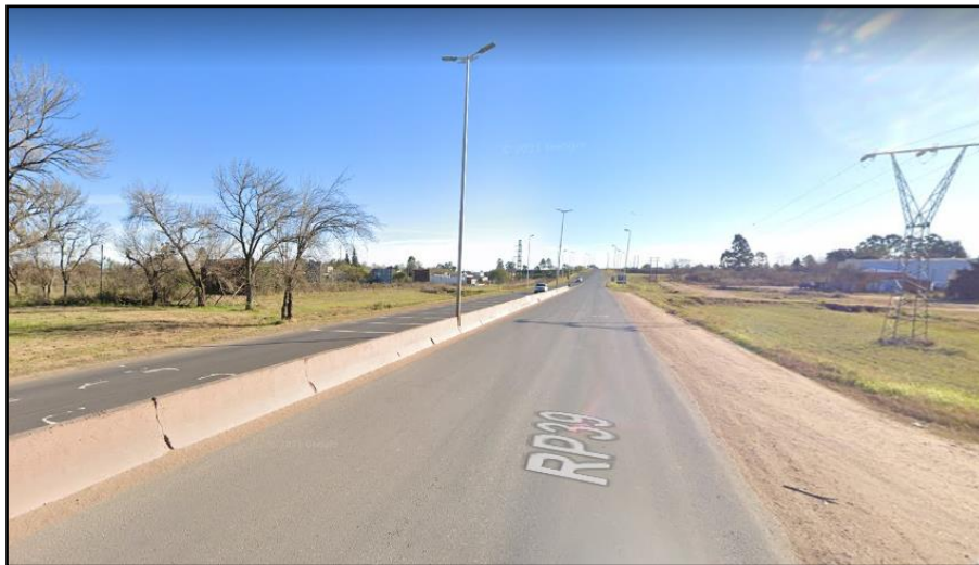
Figura 82. Estado RP N° 39, desde Rulo hasta el acceso a Concepción del Uruguay. Fuente: Google maps.
