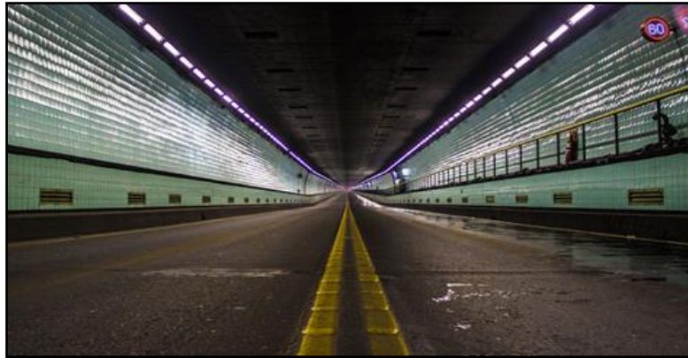
Figura 14. Tunel subfluvial Raúl Uralga – Carlos Sylvestre Begnís. Fuente: https://www.tunelsubfluvial.gov.ar/obras-y-mantenimiento/
