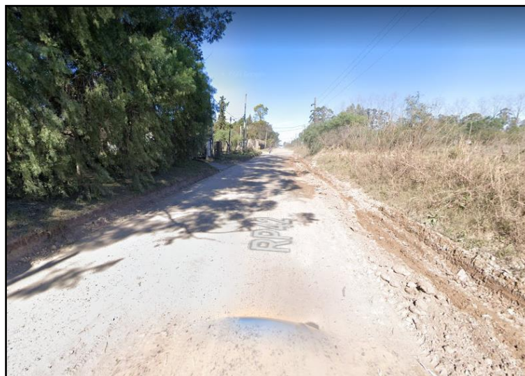
Figura 90. Estado de RP N°42. Fuente: Google maps.
