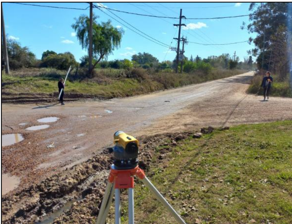
Figura 72. Nivelación sobre ruta Provincial n° 42. Fuente: Propia.
