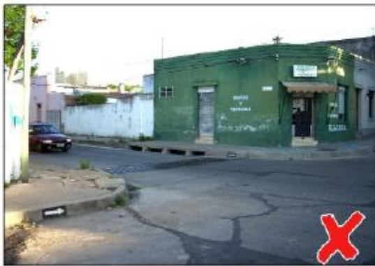
FIGURA 9 - BOCA DE TORMENTA Y REJA EN ESQUINA INTERPONIÉNDOSE CON CRUCE PEATONAL.
