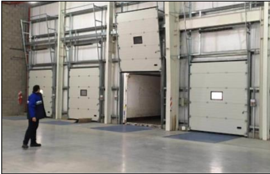
Figura 53. Instalaciones CTC. Fuente: https://www.ctcadministradora.com.ar/
