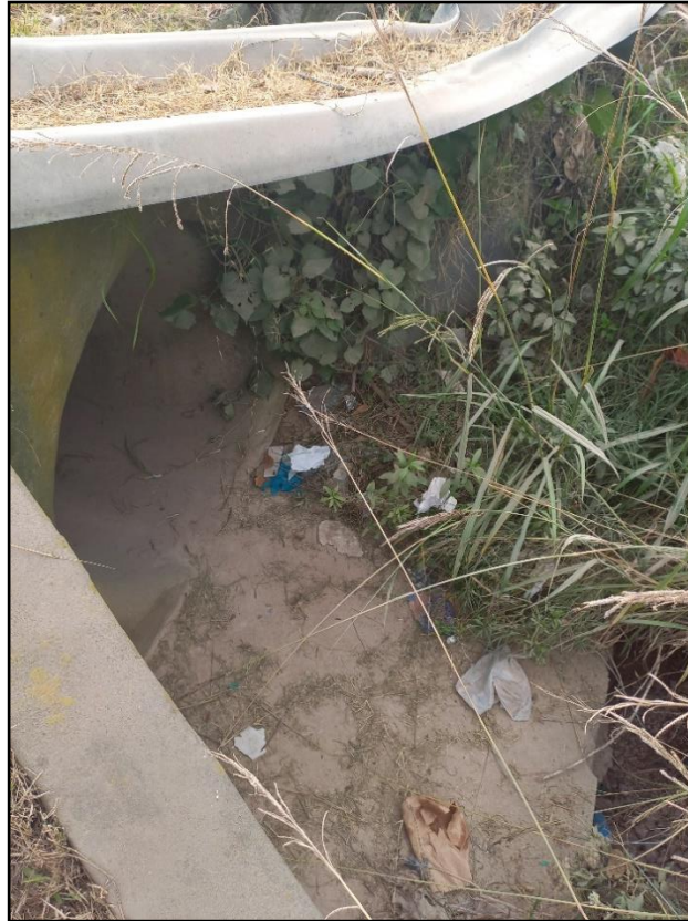
Figura 64. Caño de 1100 de hormigón intersección ruta 39 y ruta 42. Fuente: Propia.
