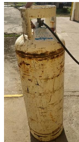
Fig. 2.2: Tanque de Combustible.
