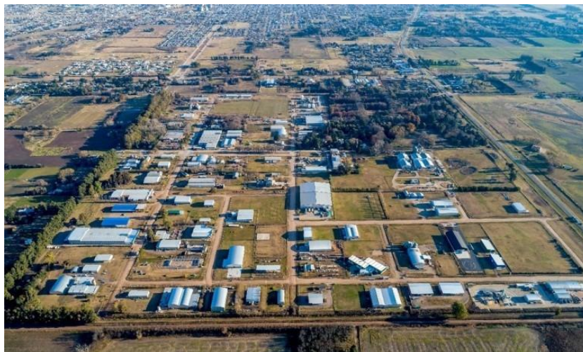
Figura 5.4 – Vista panorámica del parque industrial de Fomento de Junín Presidente Arturo Frondizi La selección del lote es en función a la disponibilidad de los mismos, en la figura 5.5 se muestra el elegido para este proyecto.
