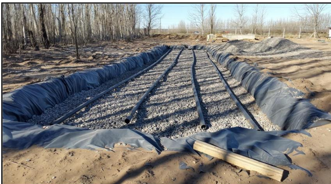
Figura.5.7. Vista de lecho de evaporación de 40 metros de largo de por 8 metros de ancho por 1 metro de profundidad 98
