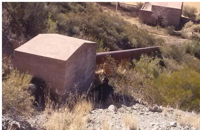
14. Sala de máquinas: es un local de dimensiones 12,15 x 12 x 5,30 m de mampostería con piso de cemento cuya función es la de proteger todo el equipamiento electromecánico que necesita la central hidroeléctrica (turbina, generador, tablero de comando, transformador, etc.).
