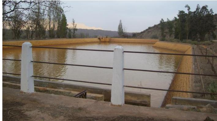
16. Divisor en Y 2: Idem 8, cuya función es la de conectar la conducción D al azud de riego o al canal de riego principal.
