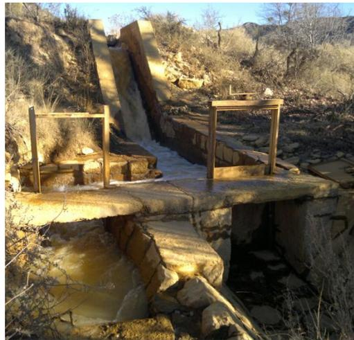
17. Canal de Riego principal: Consiste en un canal de hormigón en forma trapezoidal que alimenta al sistema de canales de riego aguas abajo.
