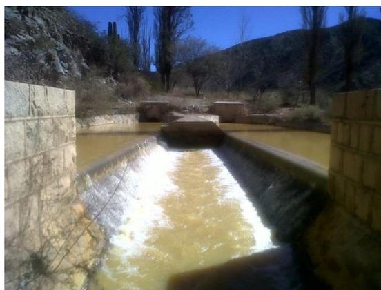
8. Divisor en Y: Consiste en una canal a cielo abierto de hormigón, con forma de Y cuya función es la de dividir el caudal de agua captado y desarenado en 2 circuitos de canales (circuito de riego y el otro circuito de la mini central hidroeléctrica). Se encuentra a continuación del desarenador 2.
