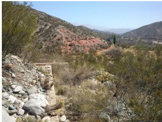
11. Pileta de carga: Es de hormigón de 55x23,20x4 m, cuya función es la de mantener un caudal de agua constante para alimentar la turbina.
