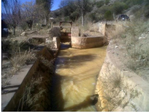
9. Canal de conducción D: Consiste en un canal de hormigón, de forma trapezoidal a cielo abierto que funciona como by-pass de la mini central hidroeléctrica.
