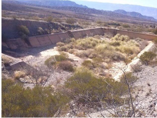
12. Canal de conducción F: De hormigón que conecta el desborde de la pileta de carga con el canal de conducción D.
