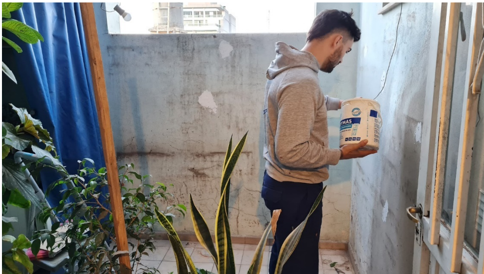
Fig. N° 51 - Masillado de huecos.
