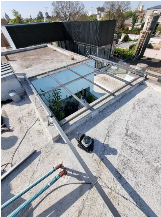
Fig. N° 55 - fabricación e instalación de toldo corredizo.
