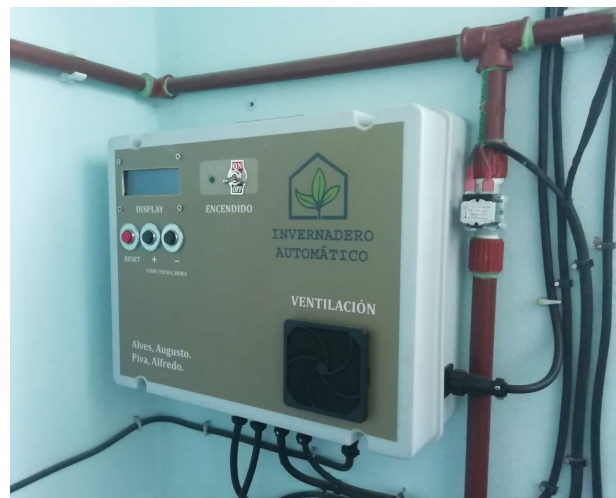
Fig. N° 44 - Ubicación de tablero en patio.
