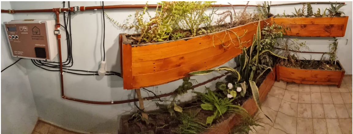
Fig. N° 54 - Plantas ya colocadas junto con gabinete de control.
