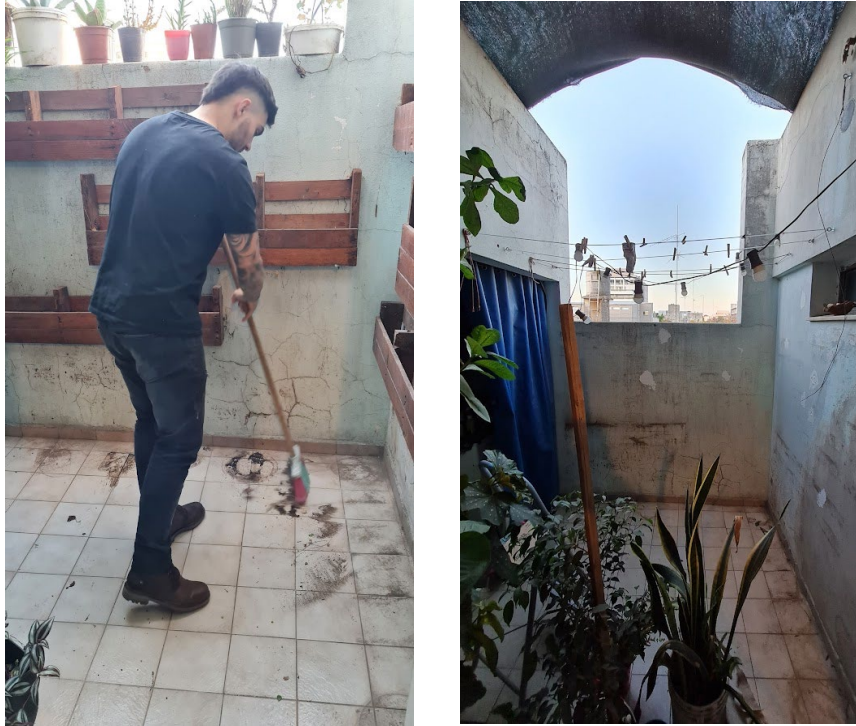
Fig. N° 50 - Limpieza del lugar.
