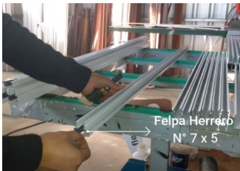
Figura 11. Colocación de felpa en perfil.
