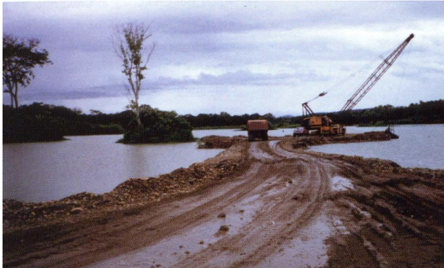
Foto N° 1-1: Operación de dragado
