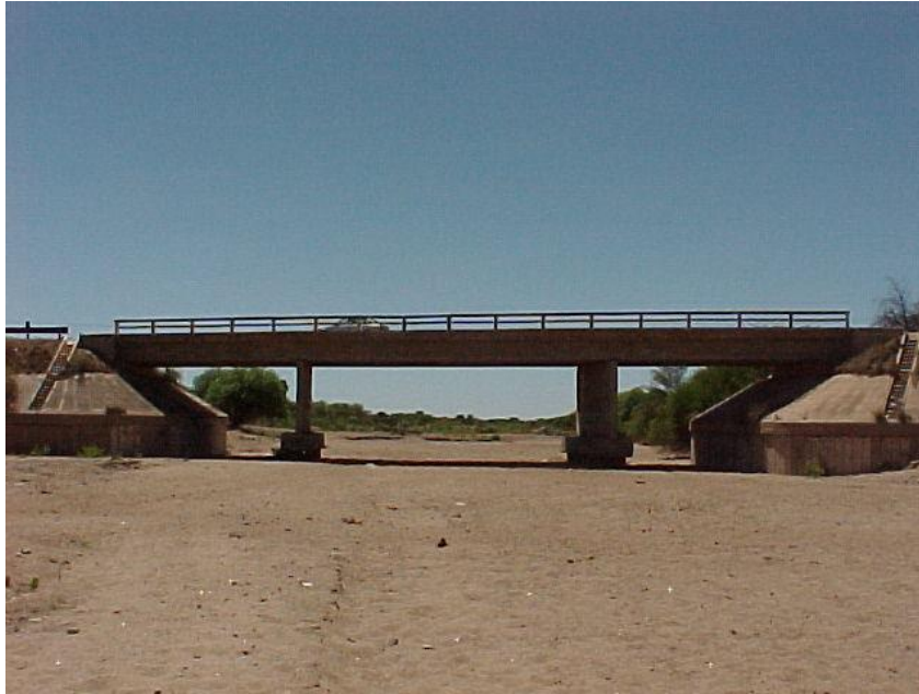
Foto N° 3-15: Puente carretero Ruta Nacional N° 38: Río Talamuyuna
