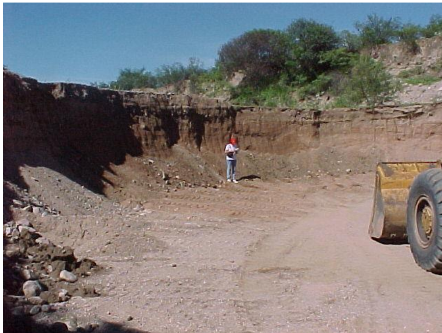
Foto N° 2-3: Sector A, material destinado a planta de hormigón.
