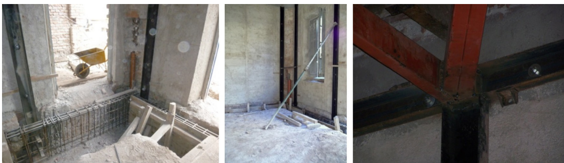
Figura 12: Refuerzo de cimientos y estructuras metálicas reversibles en columnas y vigas, Escuela Mitre, 2012
