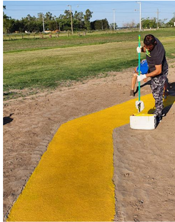
Fotografía 11: Pintado de señales de borde de pista
