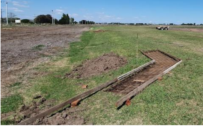
Fotografía 10: Armado de señales de borde de pista
