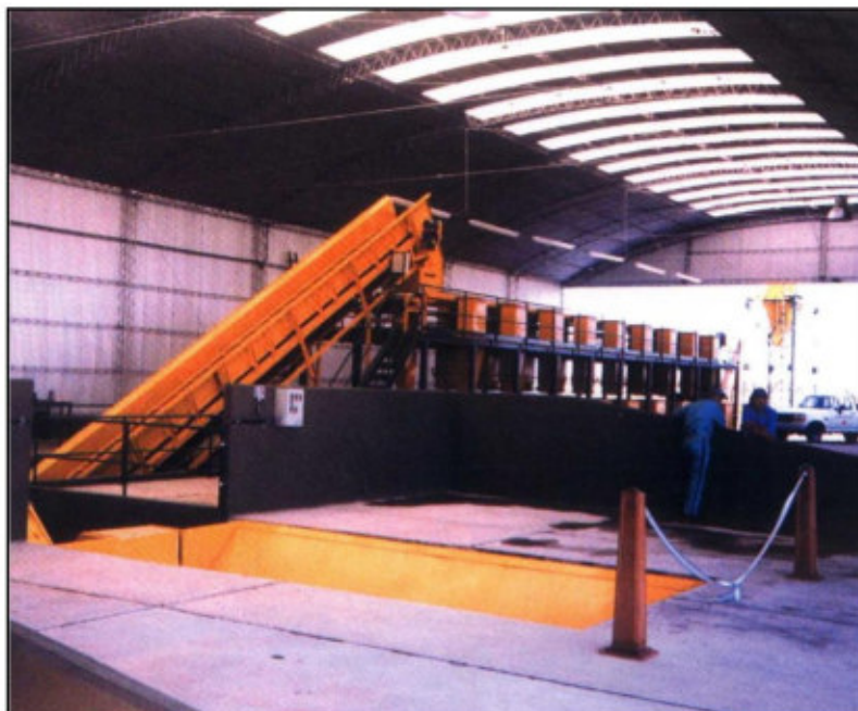
4- Vista Planta de Tratamiento: galpón con cerramiento lateral y cubierta metálica, cinta de alimentación, plataforma elevada.
