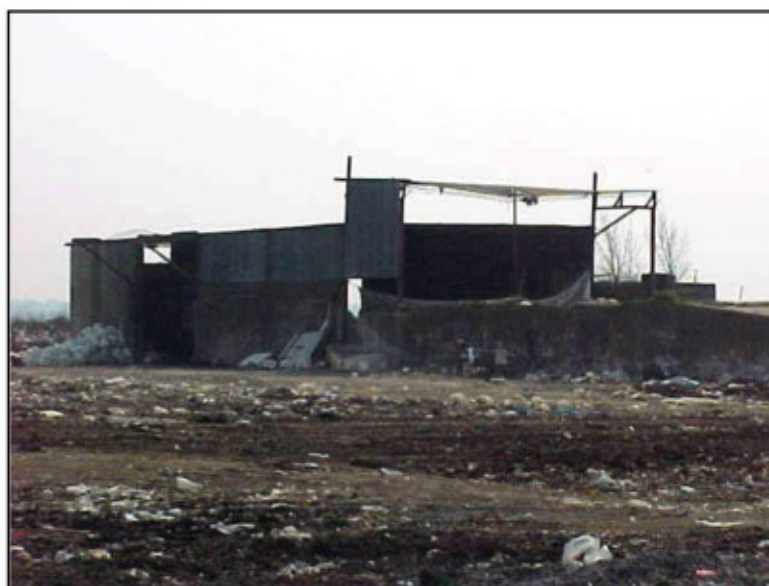
Antigua Planta de Tratamiento de RSU
