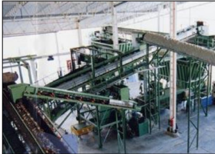
1- Instalación Planta de Tratamiento: cintas de alimentación, transportadoras, plataforma elevada con carros volcadores.
