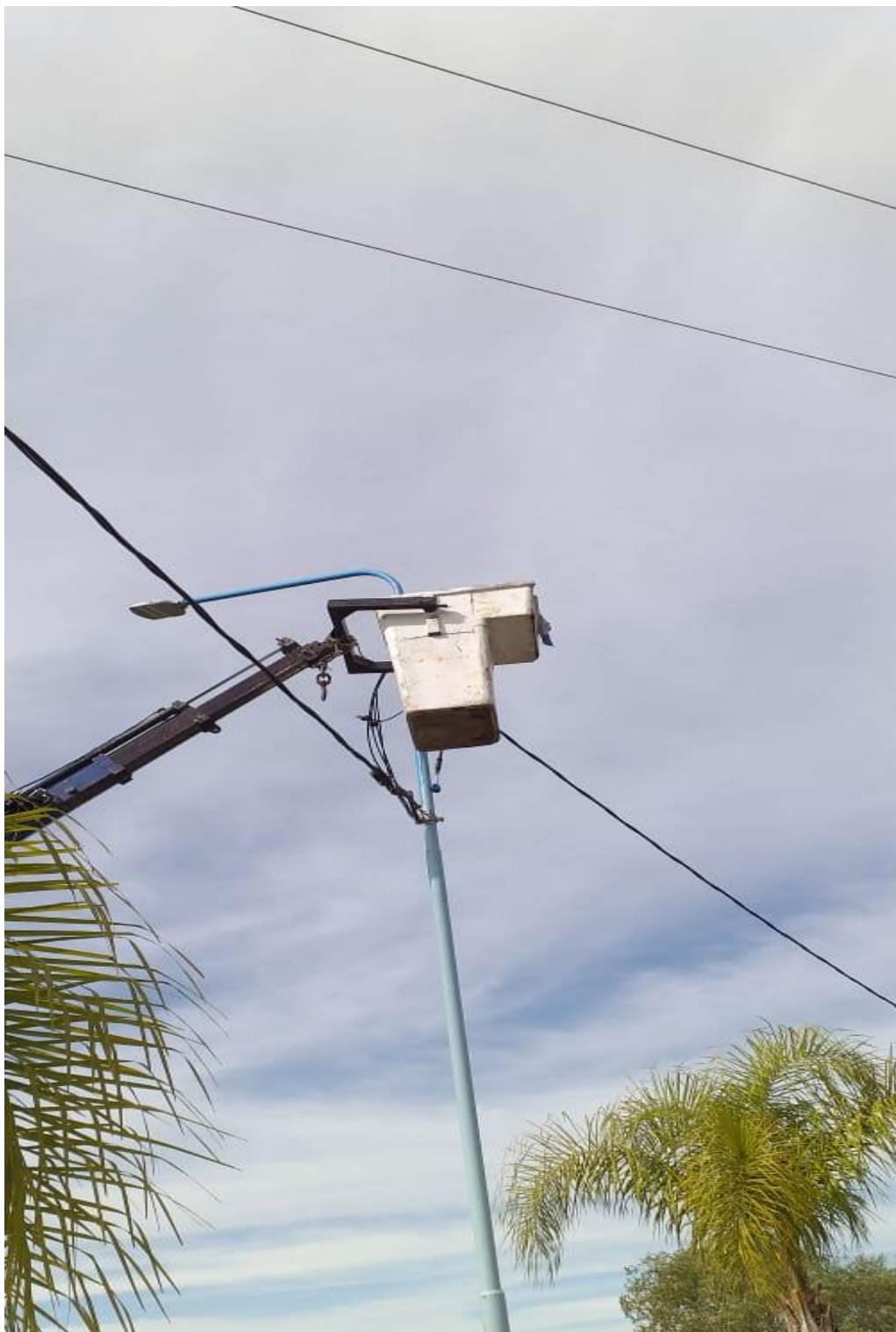
Fotografía 3. TENDIDO DE CABLE PREENSAMBLADO. Maximiliano Rodríguez
