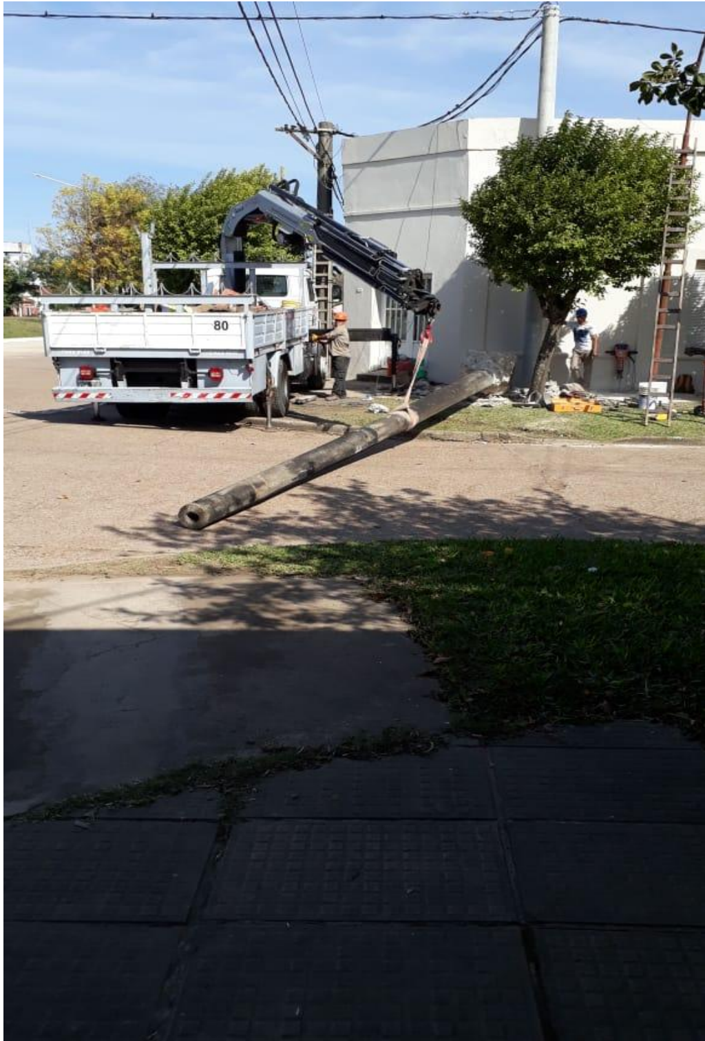
Fotografía 4. RECAMBIO DE POSTE. Maximiliano Rodríguez
