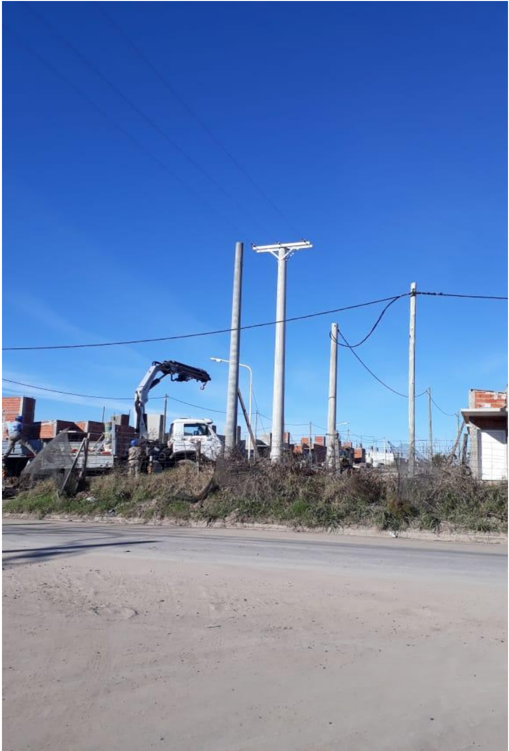
Fotografía 5. CAMBIO DE POSTE DE MEDIA TENSION. Maximiliano Rodríguez
