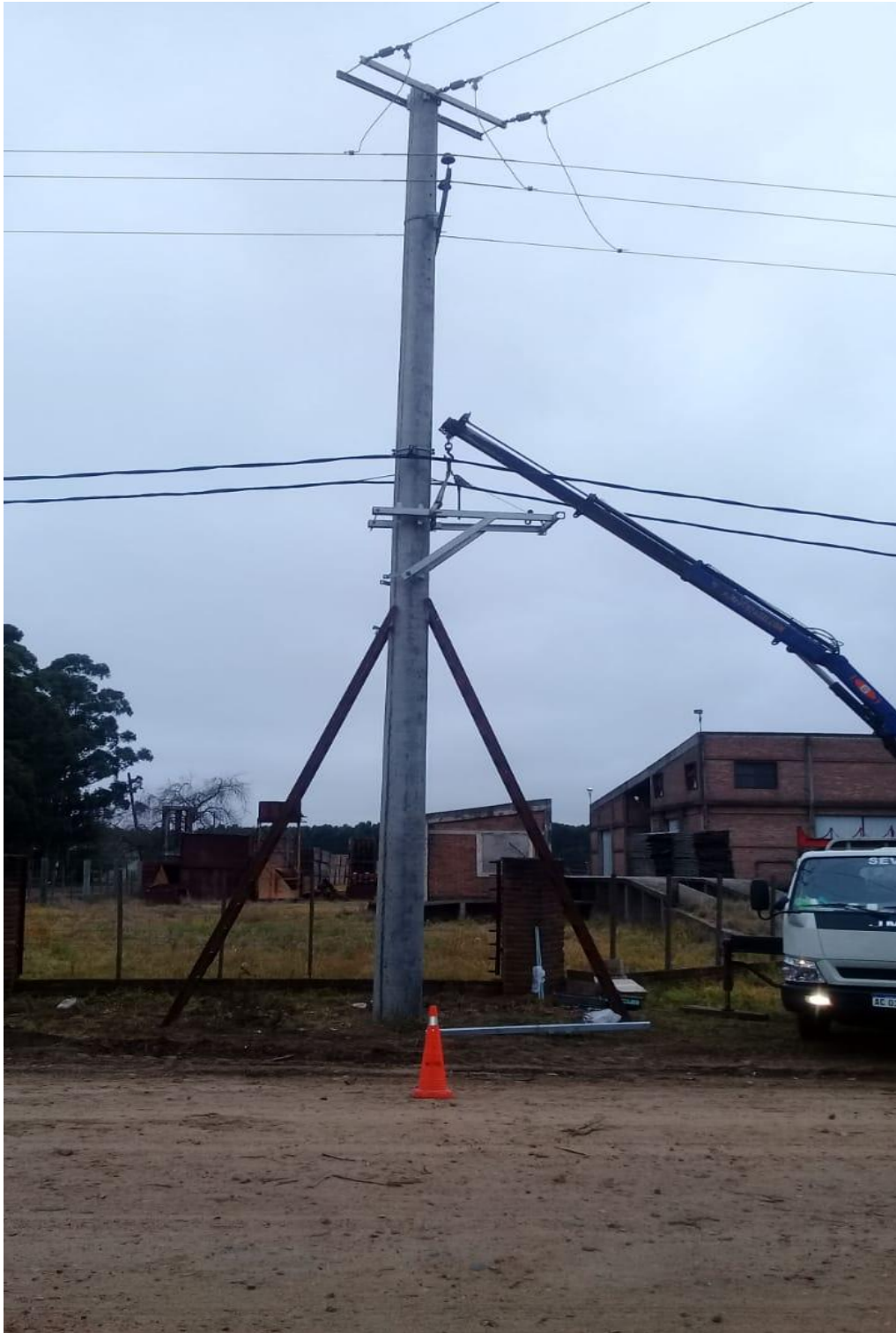
Fotografía 1. ACONDICIONAMIENTO DE LINEAS Y COLUMNAS. Maximiliano Rodríguez
