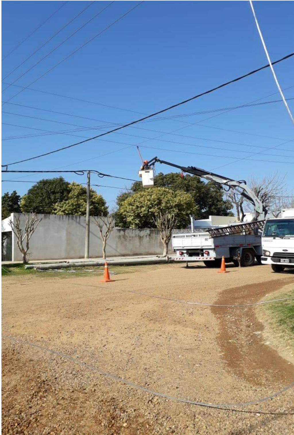
Fotografía 2. CAMBIO DE CABLEADO DE MEDIA TENSION. Maximiliano Rodríguez
