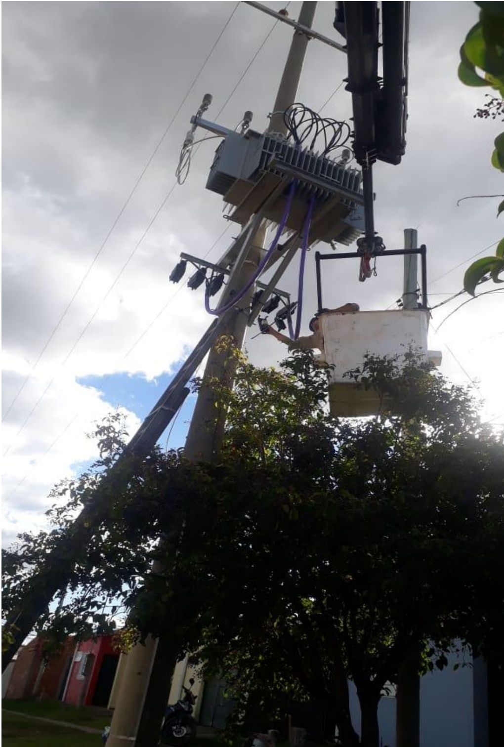
Fotografía 7. CAMBIO DE TRASFOMADOR EN PLATAFORMA ELEVADA. Maximiliano Rodríguez
