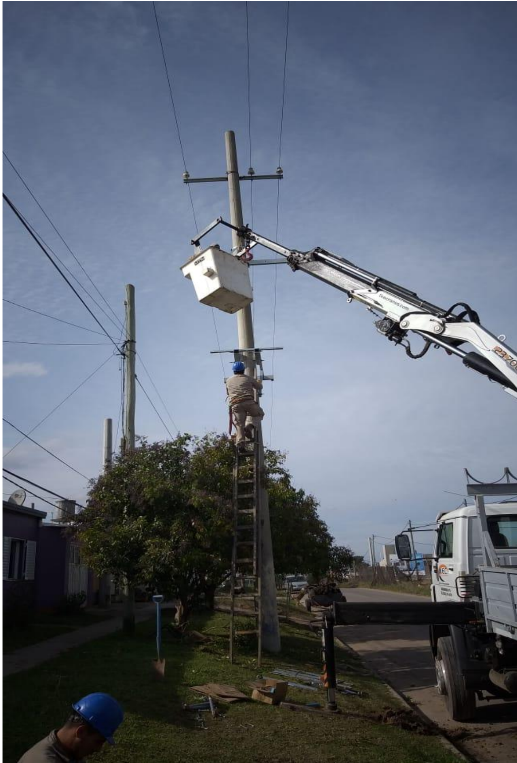
Fotografía 6. CAMBIO DE AISLADORES. Maximiliano Rodríguez
