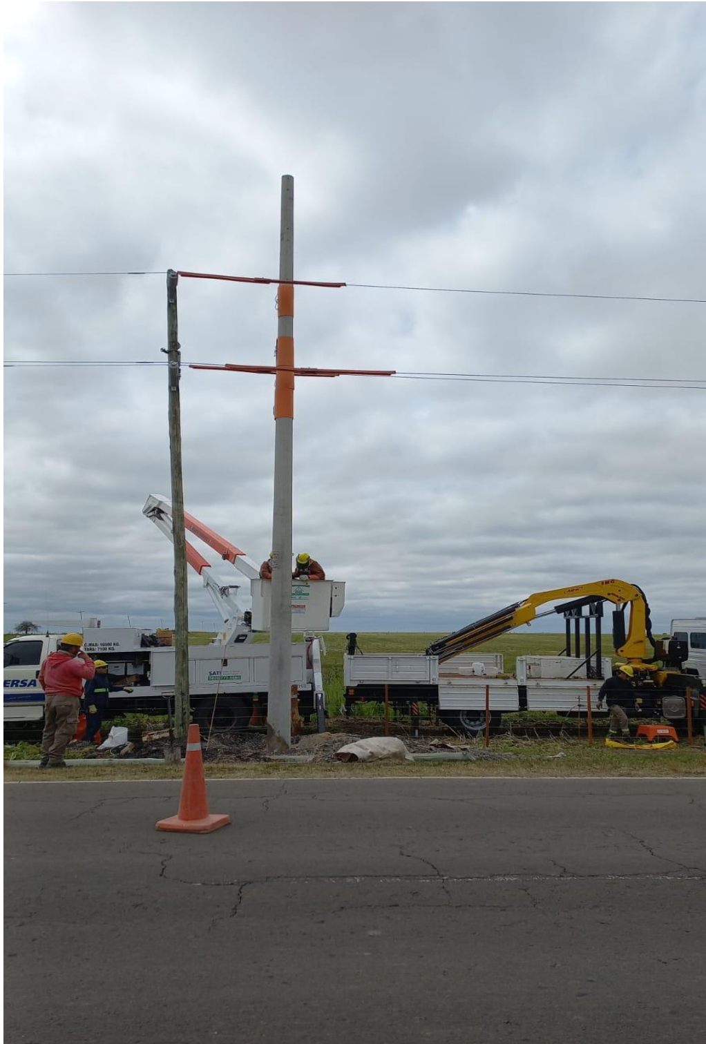
Fotografía8. CAMBIO DE POSTES. Maximiliano Rodríguez
