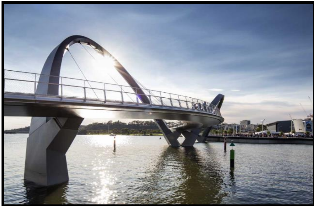
Figura 1.5 Puente Queen Elizabeth Quay - Ciudad de Perth (Archdaily, 2019).
