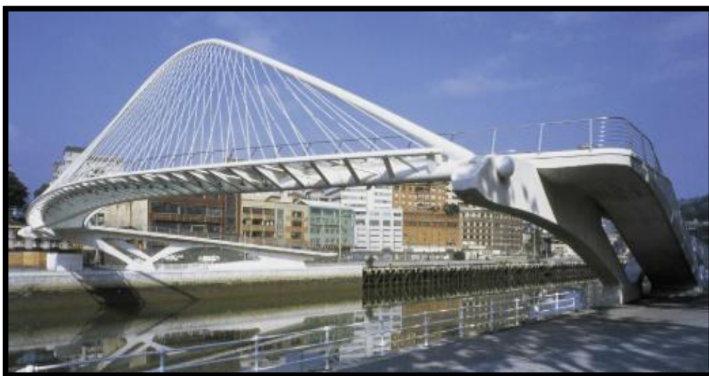
Figura 1.4 Pasarela Campo Volantín - Ciudad de Bilbao (Plasencia, 2013).
