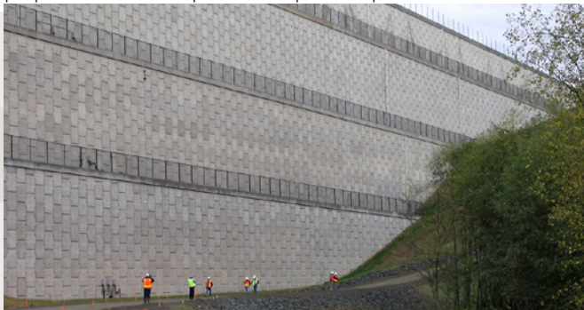
Muro de varios niveles con una altura de 45 metros (Aeropuerto SeaTac, EE. UU)
