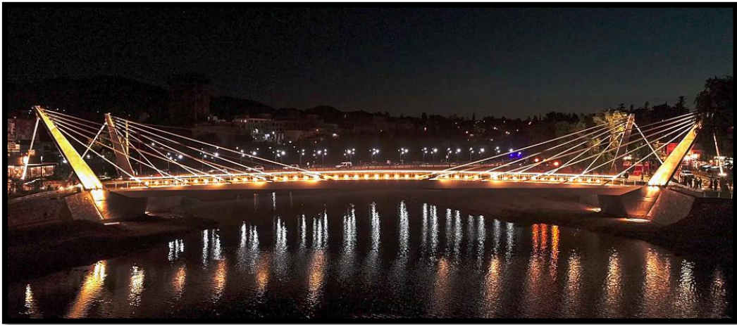
Figura 1.6 Puente del Centenario – Villa Carlos Paz (Amarante, 2019).
