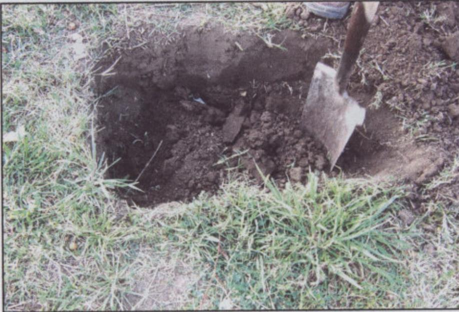
**Excavación en el terreno hasta suelo de fundación.**
