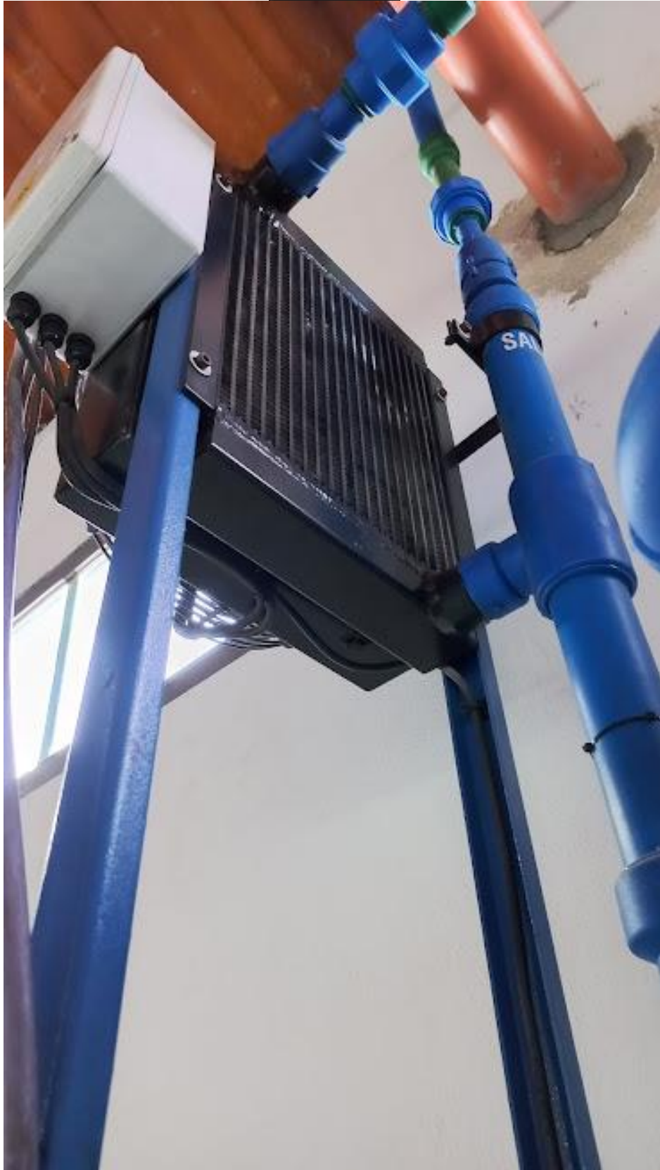
Posenfriador, conformado por un ventilador, serpentín e intercambiador de calor.
