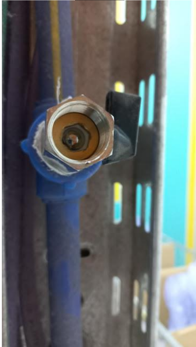
Llavín cerrado, conectado al circuito neumático.
