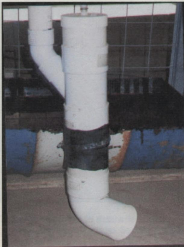
Fig. 6 Junta elástica y abrazaderas metálicas.
