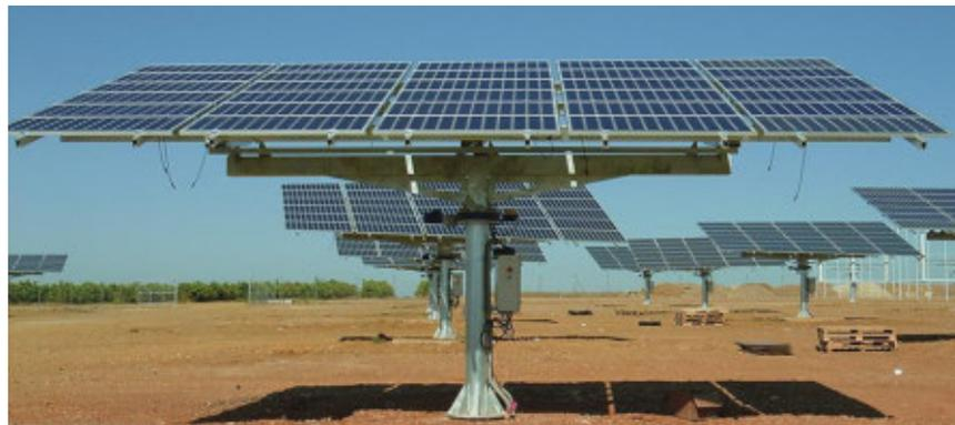
*Figura 5.5.2.1. Estructura móvil*
