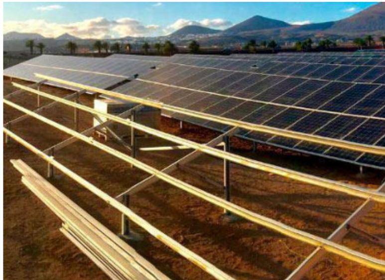
*Figura 5.5.1.1. Estructura fija*
