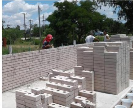
Figura 3: Seguimiento del proceso constructivo de una obra en BTC
