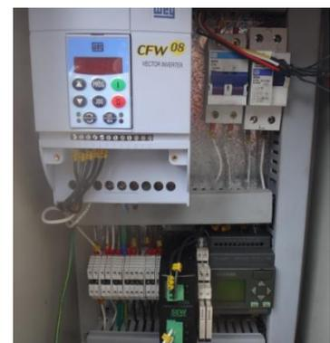
Figura 11. Tablero de PLC y reguladores
