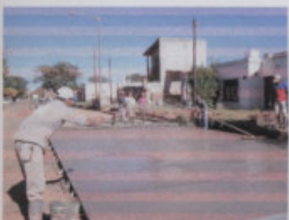
Distribución de la membrana de curado, para proteger el material del viento y el sol (secado superficial)
