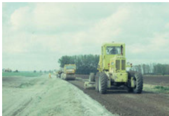
Compactación y Perfilado con Motoniveladora
