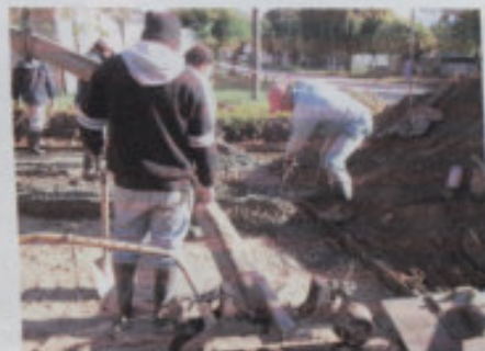
Comienzo del hormigonado (previamente debe haberse agregado humedad al suelo)
