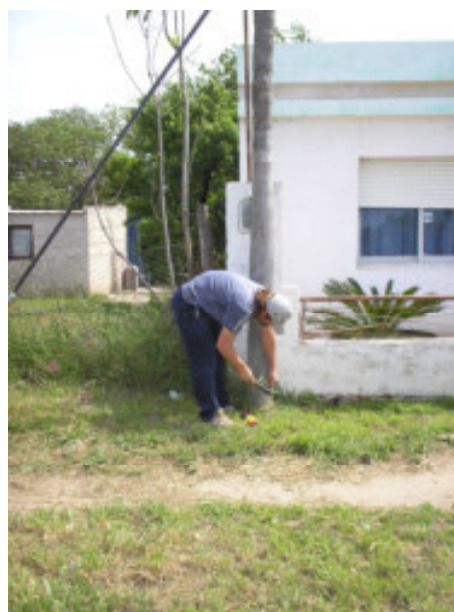
Colocación de los pinchotes
