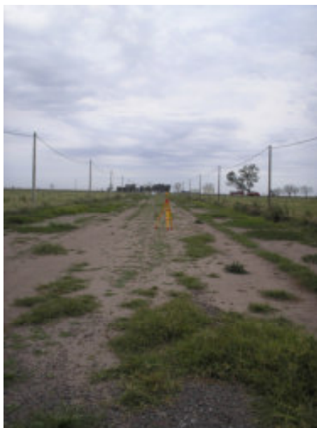
Estado actual sector interno Área Industrial
