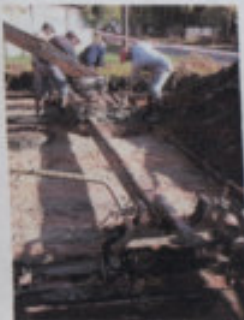
Comienzo del hormigonado (previamente debe haberse agregado humedad al suelo)
