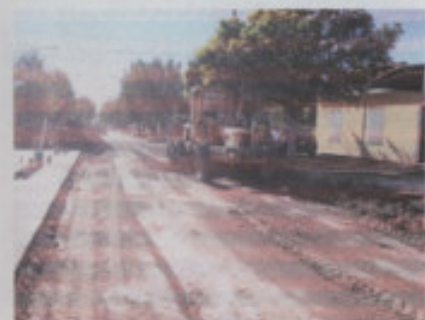
Desmoldado pavimento ya hormigonado y preparación de la subrasante (1/2 calzada restante)
