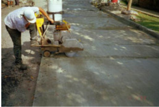
Aserrado de juntas de contracción en el hormigón endurecido
