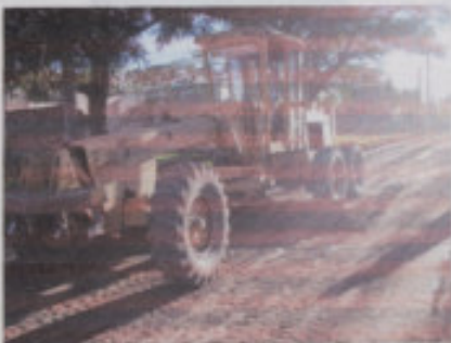
Perfilado subrasante para lograr el espesor deseado, en función del gálibo de la regla vibradora
