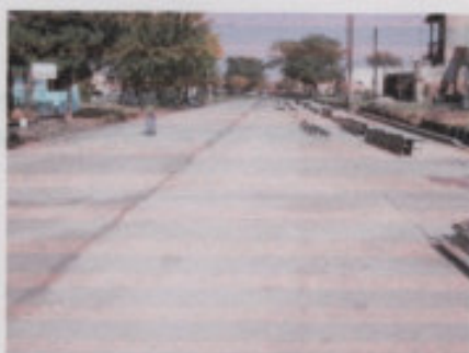
Moldeo y llenado de los cordones restantes y desmoldar y revocar los cordones ya hormigonados
