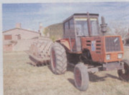
Preparación de la subrasante – Compactación del suelo
