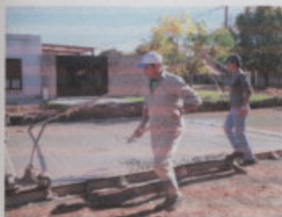
Fratachado de la mezcla
