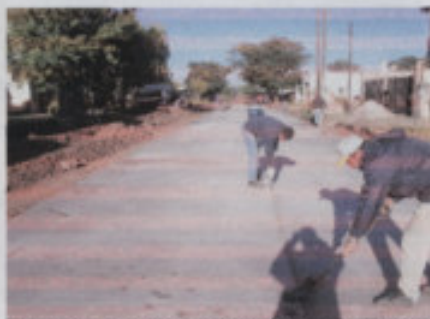
Marcajo Juntas longitudinales y transversales
