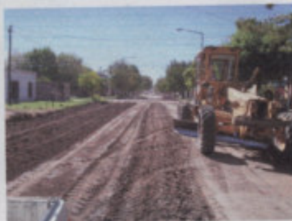
Preparación de la subrasante
