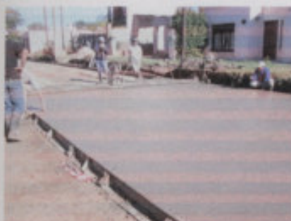
Marcado de las juntas y colocación de cartón prensado en el hormigón fresco
