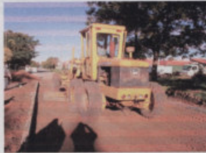
Perfilado subrasante para lograr el espesor deseado, en función del gálibo de la regla vibradora
