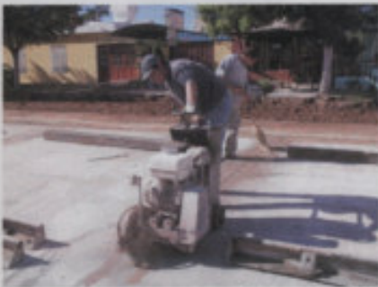
Aserrado de juntas transversales
