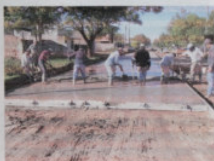
Terminación del trabajo
