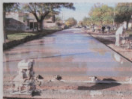
Pavimento terminado (fresco)
