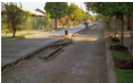
Moldes metálicos de base
