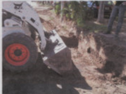
Apertura y de reacondicionamiento de baches en la subrasante
