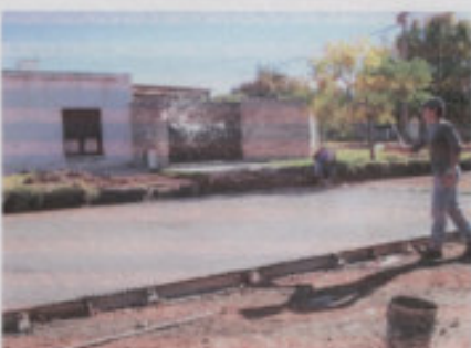
Distribución de la membrana de curado, para proteger el material del viento y el sol (secado superficial)
