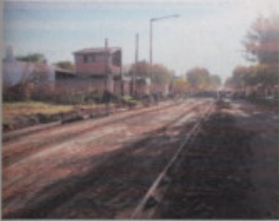
Limpieza de la subrasante
