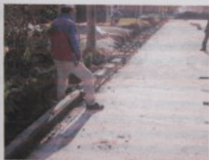
Moldeo y llenado de los cordones restantes y desmoldar y revocar los cordones ya hormigonados
