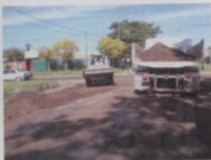
Preparación de la subrasante – Compactación del suelo
