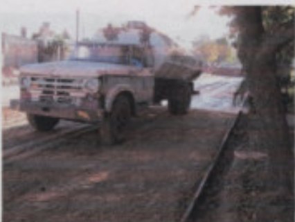
Colocación de la capa de arena y riego de la subrasante
