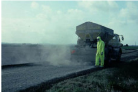
Dosificación del cemento
