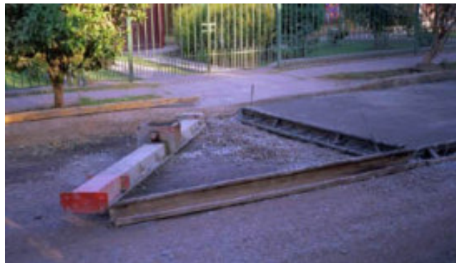
Junta de construcción
