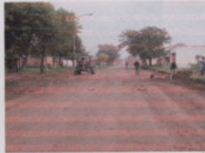
Nivelación de la subrasante a fin de obtener una superficie lisa, compacta y homogénea
