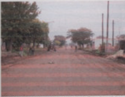
Nivelación de la subrasante a fin de obtener una superficie lisa, compacta y homogénea
