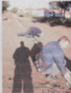
Marcado de las losas (juntas)
