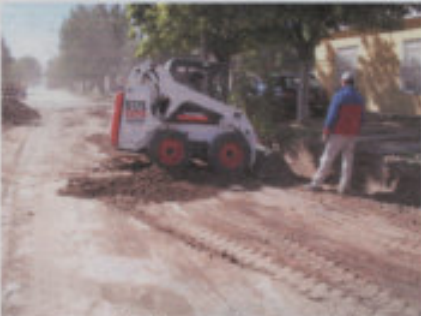
Apertura y de reacondicionamiento de baches en la subrasante
