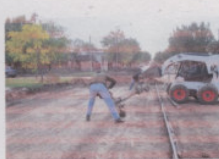
Colocación de la regla vibradora
