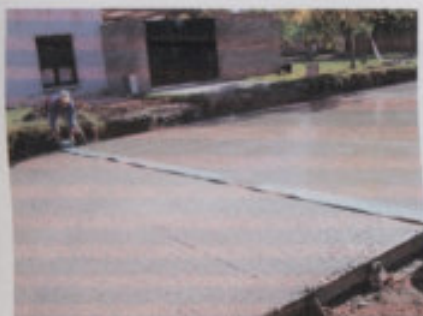
Terminación superficial con una cinta
