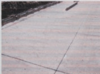
Moldeo cordones y colocación junta - Llenado de juntas del pavimento con emulsión asfáltica
