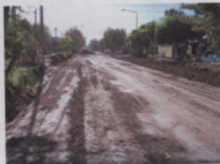
Preparación de la subrasante – Compactación del suelo
