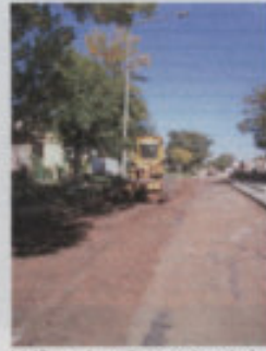
Perfilado y compactación de la subrasante (1/2 calzada restante)
