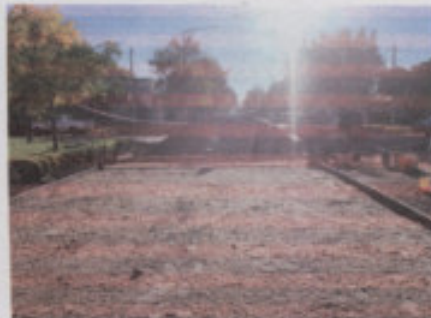
Preparación de la capa de arena que se coloca sobre la subrasante para disminuir la fricción entre el hormigón y la base
