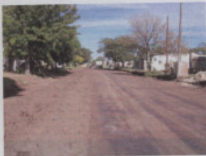
Preparación de la subrasante – Compactación del suelo
