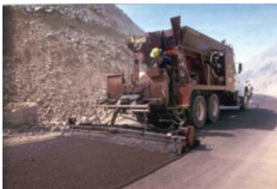
Construcción carpeta rodamiento
