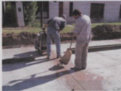
Aserrado de juntas transversales
