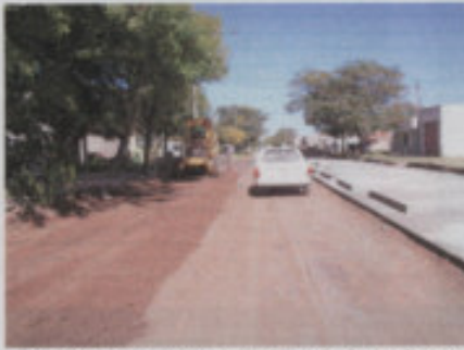
Perfilado y compactación de la subrasante (1/2 calzada restante)
