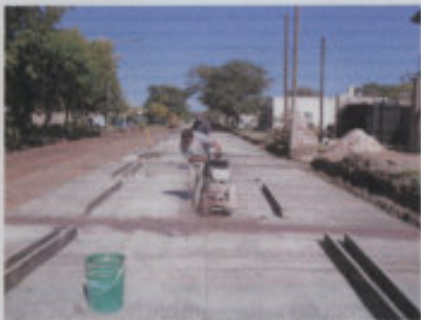
Aserrado de juntas longitudinales
