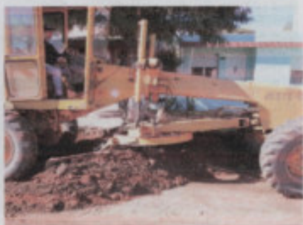
Desmoldado pavimento ya hormigonado y preparación de la subrasante (1/2 calzada restante)
