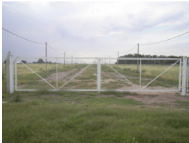
Acceso principal Área Industrial
