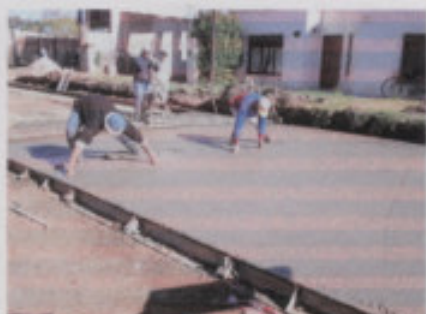
Marcado de las juntas y colocación de cartón prensado en el hormigón fresco
