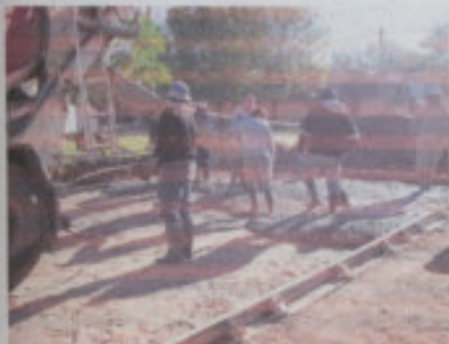
Distribución del hormigón y avance de la regla vibradora
