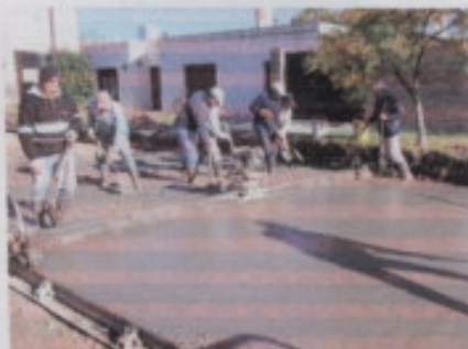
Distribución del hormigón y avance de la regla vibradora
