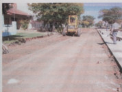
Perfilado subrasante (1/2 calzada)
