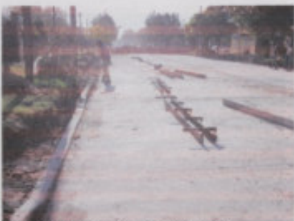
Hormigonado 1/2 calzada restante y hormigonado de los cordones
