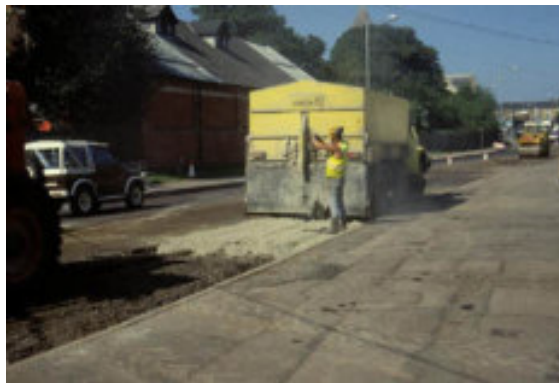
Dosificación del cemento
