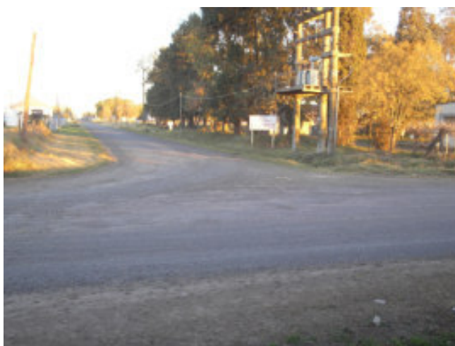
Intersección Calle Pública N° 19 y Av. Córdoba
