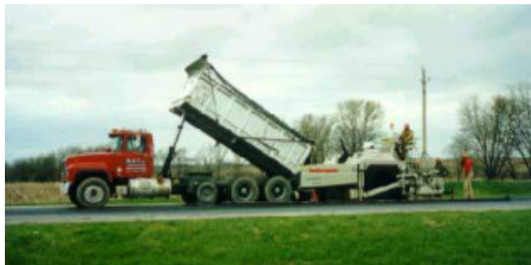
Transporte y distribución del material
