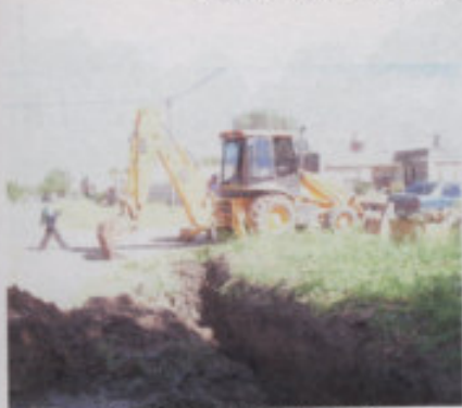
Limpieza de las cunetas
