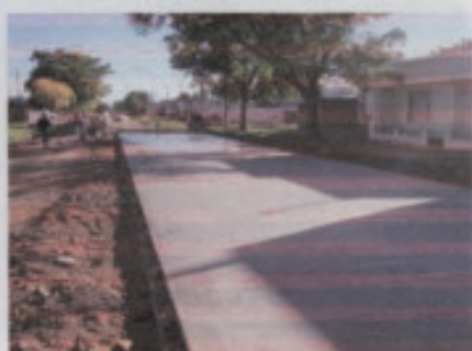
Pavimento terminado (fresco)
