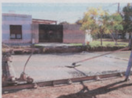
Fratachado de la mezcla
