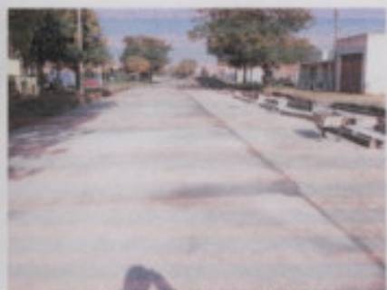
Hormigonado 1/2 calzada restante y hormigonado de los cordones
