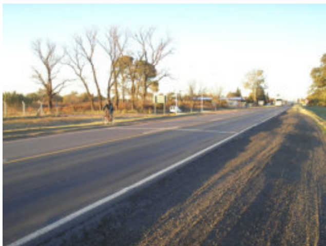
Intersección Ruta Nac. N° 33 y Desvío Tránsito Pesado
