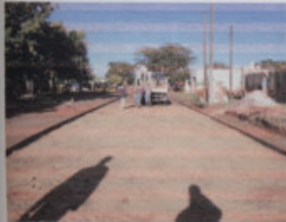
Preparación de la capa de arena que se coloca sobre la subrasante para disminuir la fricción entre el hormigón y la base
