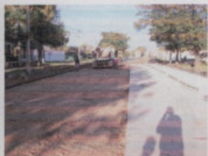
Colocación de la capa de arena y riego de la subrasante
