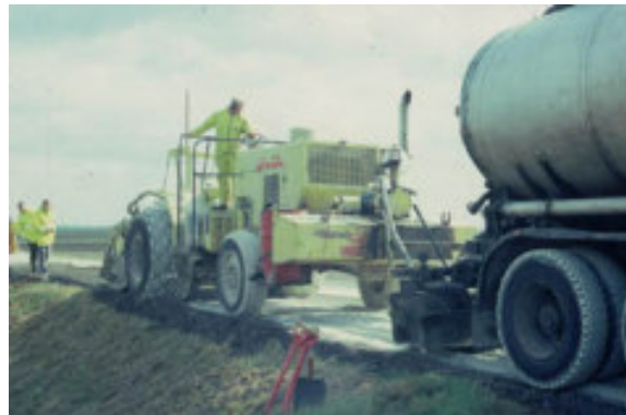
Proceso de Mezclado con el Asfalto
