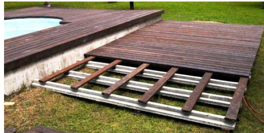
Ilustración 49 - Instalación sobre tierra paso 2. Ejemplo
