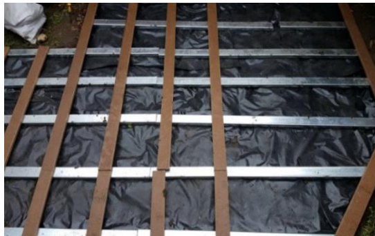
Ilustración 46 - Instalación sobre tierra paso 1. Ejemplo
