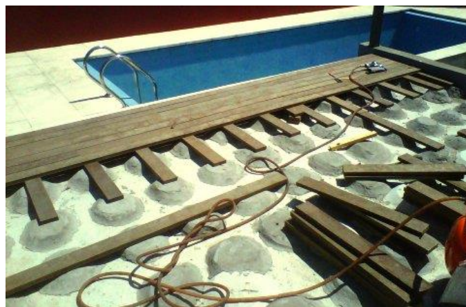
Ilustración 50 - Apoyos sobre contrapisos
