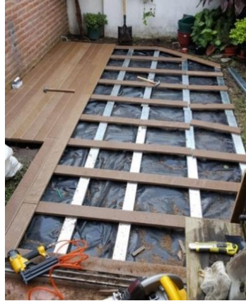
Ilustración 48 - Instalación sobre tierra paso 2. Ejemplo
