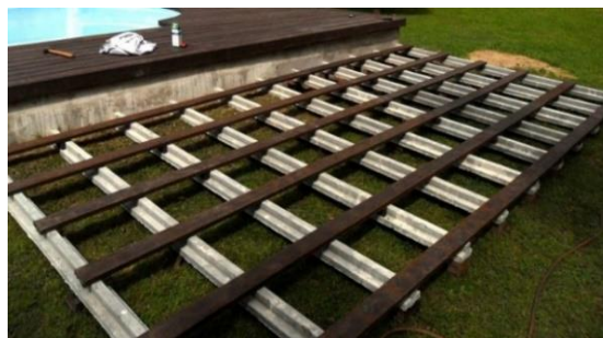
Ilustración 47 - Instalación sobre tierra paso 1. Ejemplo
