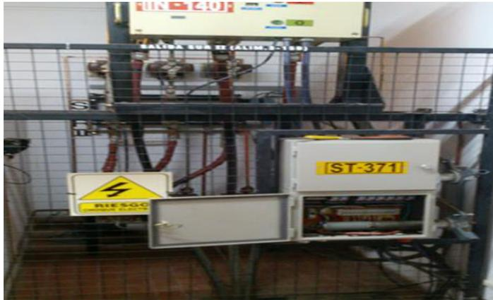
**Figura 9:** Alimentador zona urbana 13,2kV y medición indirecta del despacho
