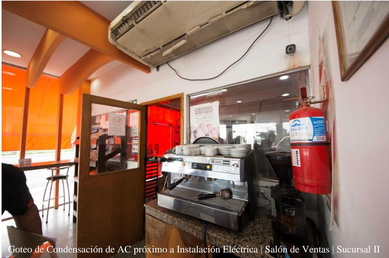
Goteo de Condensación de AC próximo a Instalación Eléctrica | Salón de Ventas | Sucursal II
