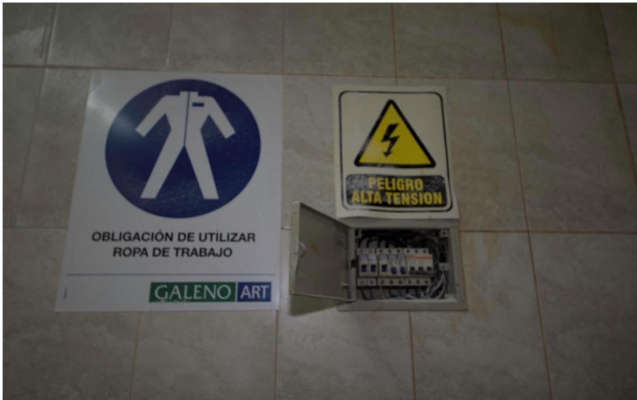
Falta Protección de Bornes en Tablero Eléctrico | Sector de Amasado | Producción | Casa Central
