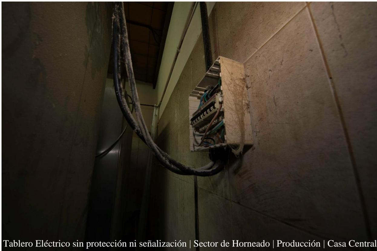
Tablero Eléctrico sin protección ni señalización | Sector de Horneado | Producción | Casa Central
