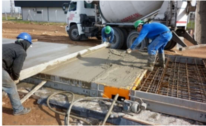
Figura 152| Hormigonado, encofrado y diseño de balanzas. Fuente: https://www.sipel.com.ar/uploads/Balanza%20de%20Camiones/Folleto_camiones.pdf
