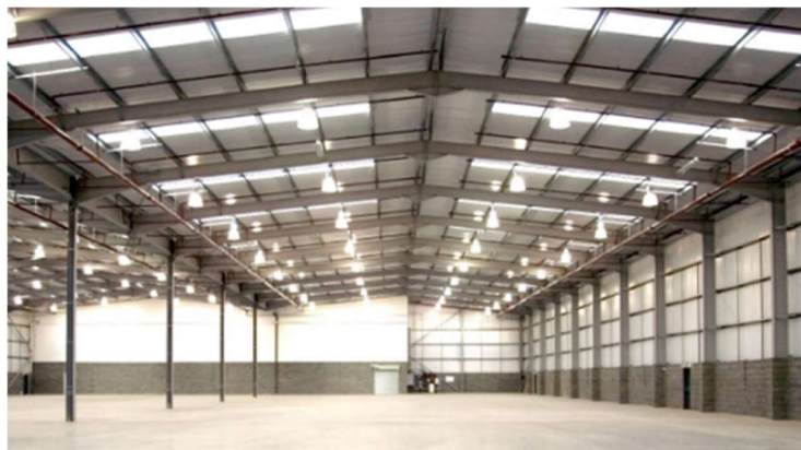
Figura 207| Colocación de lámparas colgantes de la estructura. Fuente: https://ledsindriver.es/blog/soluciones-de-alumbrado-led-para-naves-industriales/
