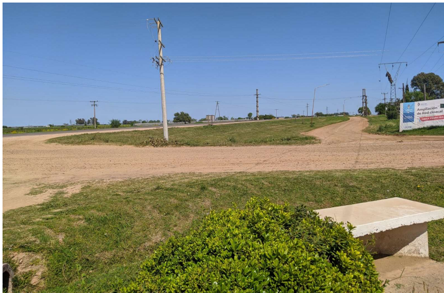
Figura 65| Vista desde la calle privada hacia la paralela norte y la Ruta Provincial N°39. Elaboración propia.
