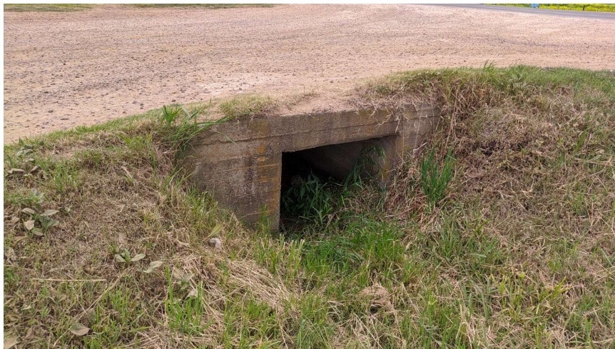
Figura 67| Visual de la obra de arte, con una altura de 0,8m desde la base hasta la viga superior, y con un ancho de boca de 1m, de sección rectangular, en hormigón armado de 2cm de espesor y forma de cuña. Largo aproximado: 14,05m. Elaboración propia
