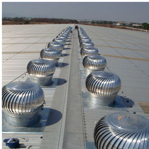
Figura 208| Domos de ventilación. Fuente: https://www.extractoreseolicos.com/ventilacion-eolica/
