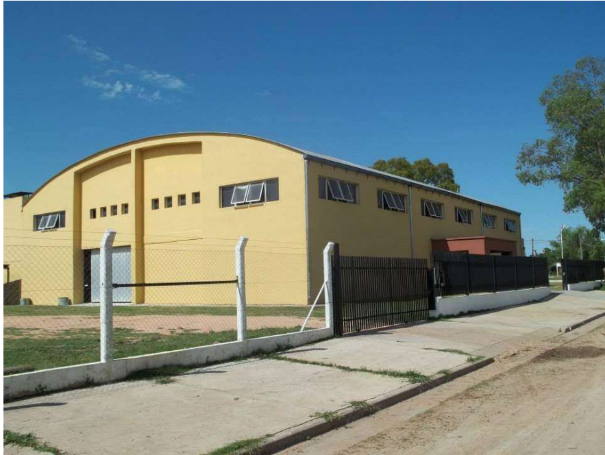
Figura 24| Vista actual del Salón de Usos Múltiples de Herrera. Elaboración propia
