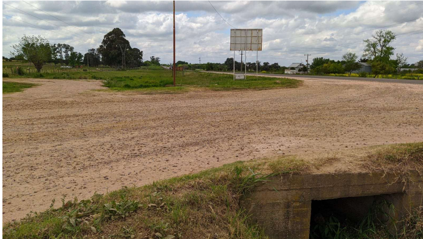
Figura 66| Vista de la Ruta Provincial N°39 y una calle privada desde la boca de entrada de la alcantarilla presente. Elaboración propia
