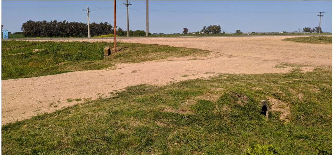
Figura 64| Visual desde la paralela Norte a Ruta Provincial N°39, donde puede evidenciarse otra alcantarilla más pequeña, circular, de 0,2m de radio. Elaboración propia
