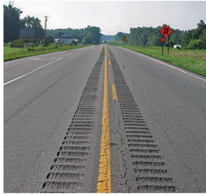
Figura 100| Demarcación horizontal en calzada para aumentar la prioridad de la línea de eje. Fuente: (Dirección Nacional de Vialidad, 2013, Señalamiento horizontal)
