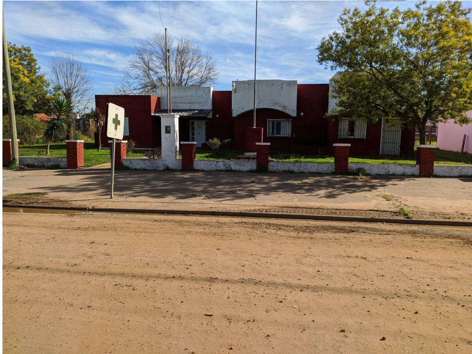
Figura 28| Vista actual del Centro de Salud de Herrera, de elaboración propia
