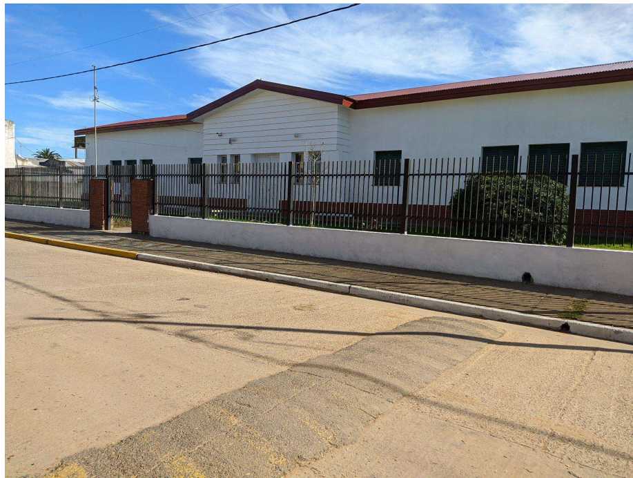
Figura 8| Imagen actual de la Escuela Primaria N°21 “Alberto Larroque”, de elaboración propia
