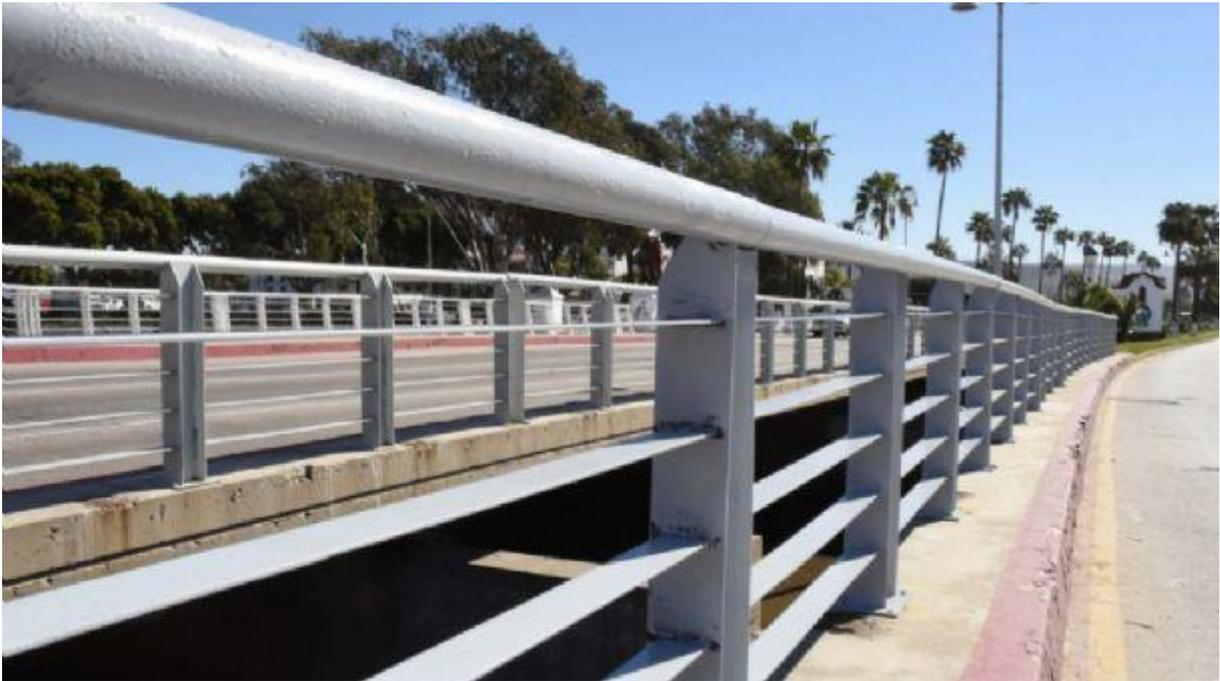
Figura 5.84 Anteproyecto hidráulico: baranda de seguridad.
