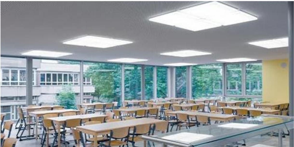
Figura 5.55 Anteproyecto arquitectónico: iluminaria LED empotrable para techos.
