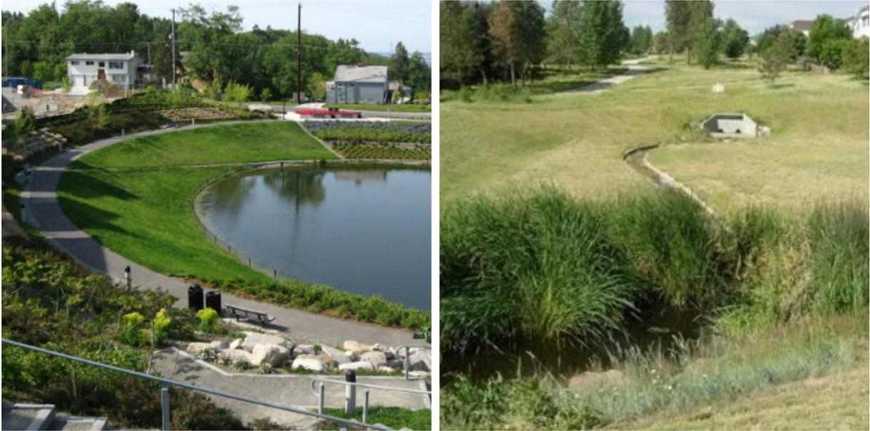
Figura 5.85 Anteproyecto hidráulico: izq. laguna de retención, der. estanque de retención.
