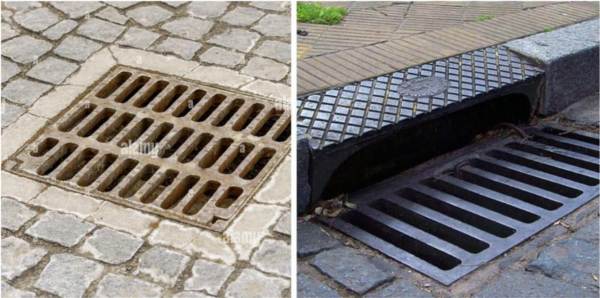
Figura 5.156 Anteproyecto vial: drenaje – rejas de desagüe.
