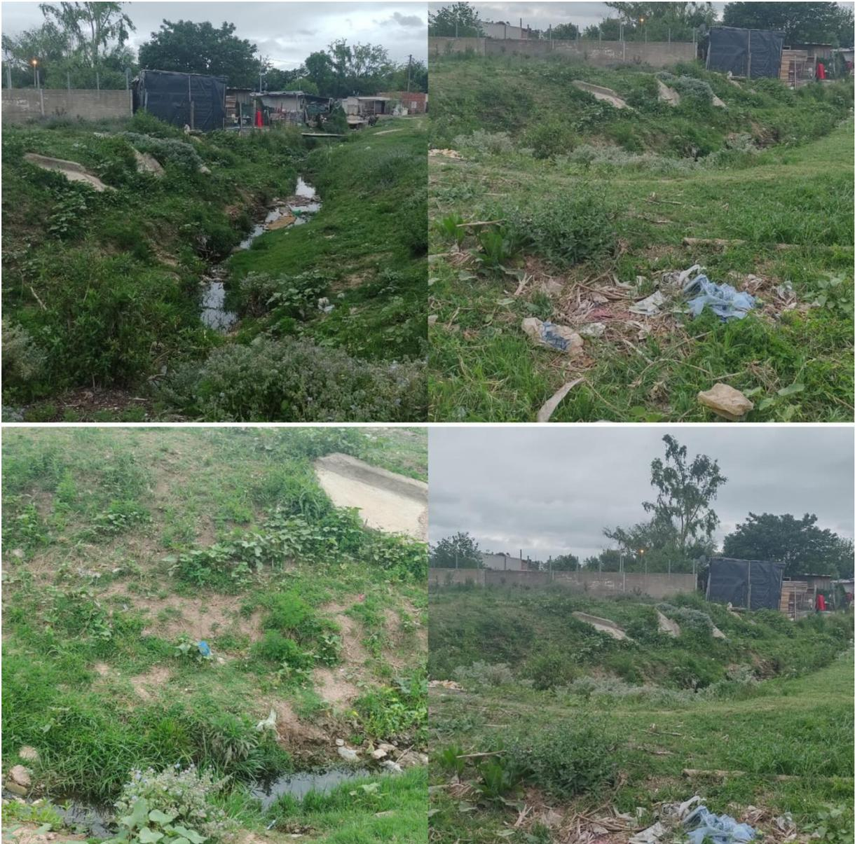
Figura 5.72 Anteproyecto hidráulico: estado del canal a cielo abierto cuenca Mosconi.
