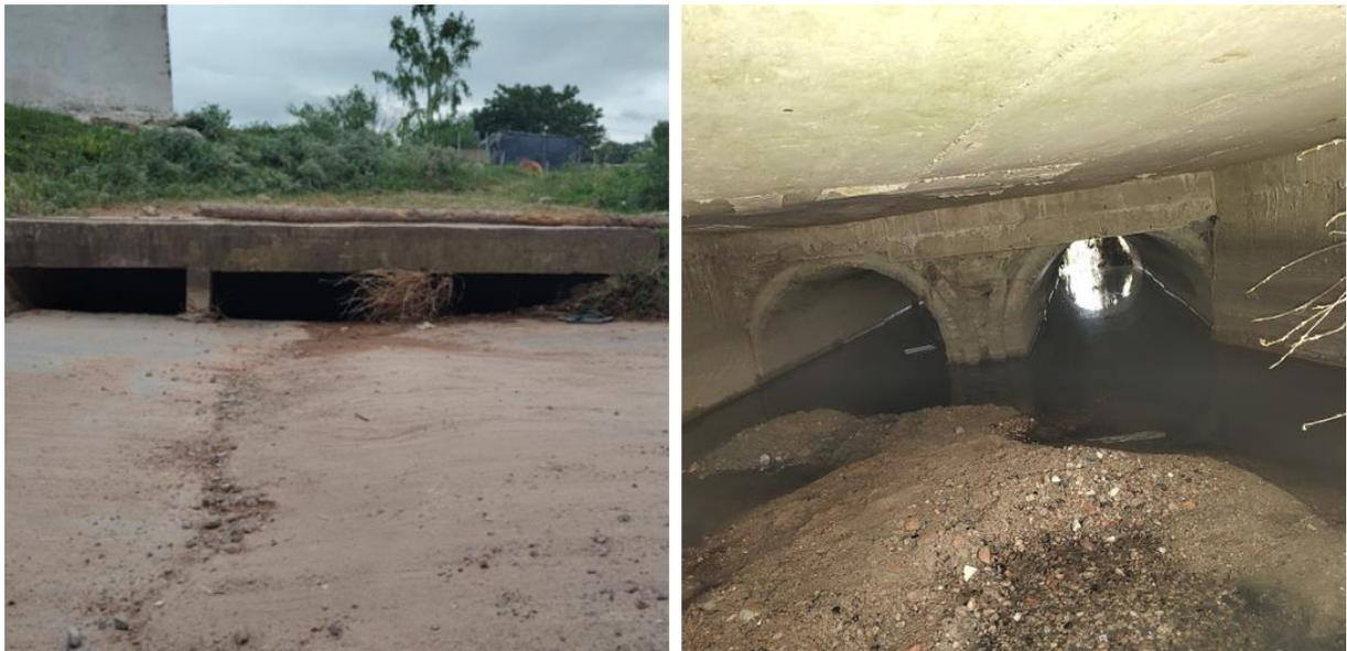
Figura 5.66 Anteproyecto hidráulico: relevamiento de alcantarilla para conducir el agua de calle 11 del Norte.
