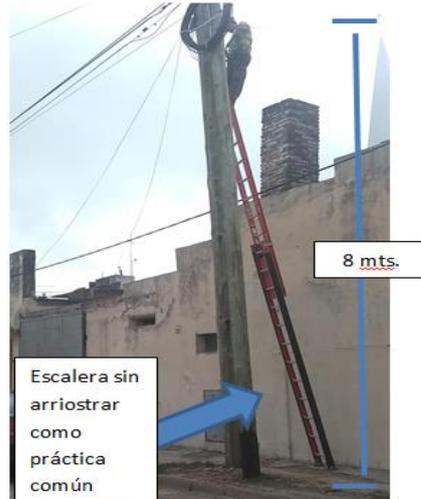
En la foto de la izq. se observa un cinturón de liniero sin rodear firmemente el poste, por lo que una caída por desplazamiento de escalera, terminaría sin duda con el operario impactando contra el suelo.
