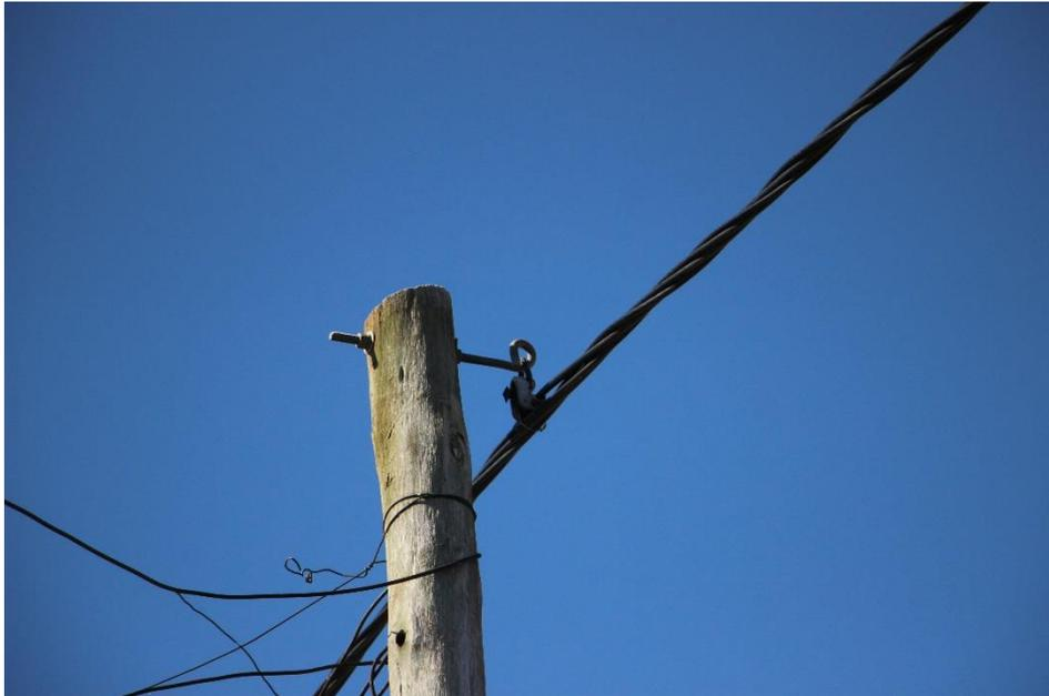
Tilla sobre poste de eucaliptus para soporte de cable preensamblado (foto propia)
