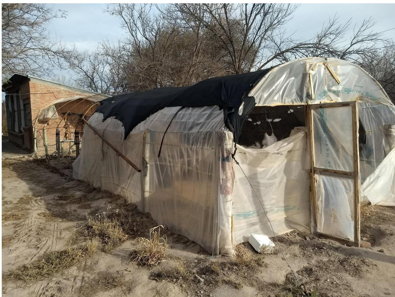
*Fig. 28: Estructura de semi túnel.*
