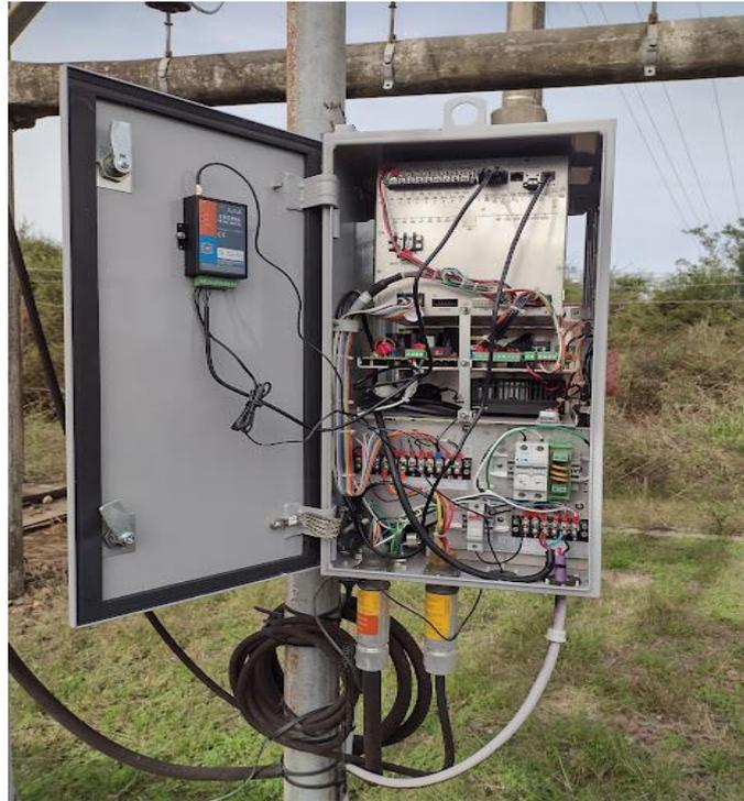
Fig. 53-Módem instalado en Reconector Cooper
