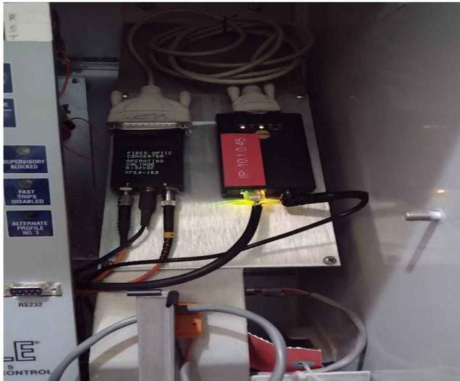
*Fig. 61- Comunicación convertor de FO- DB25. Convertor DB9- Ethernet*
