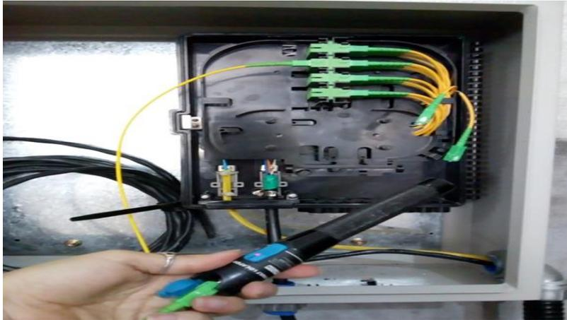
*Fig. 28- Patchera Sala de Máquinas*
