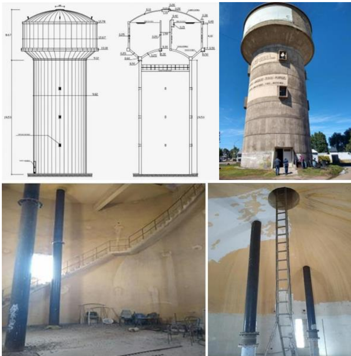
Ilustración 13: Tanque hidráulico dentro del PI. Fuente: Elaboración propia.
