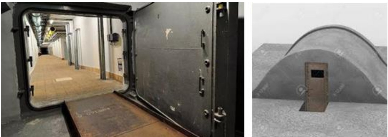
Ilustración 17: Ejemplos de espacios de confinamiento. Fuente: Internet.
