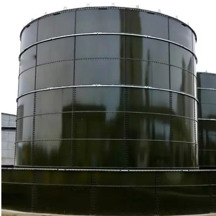
Figura N°50: Tanque ecualizador para efluentes
