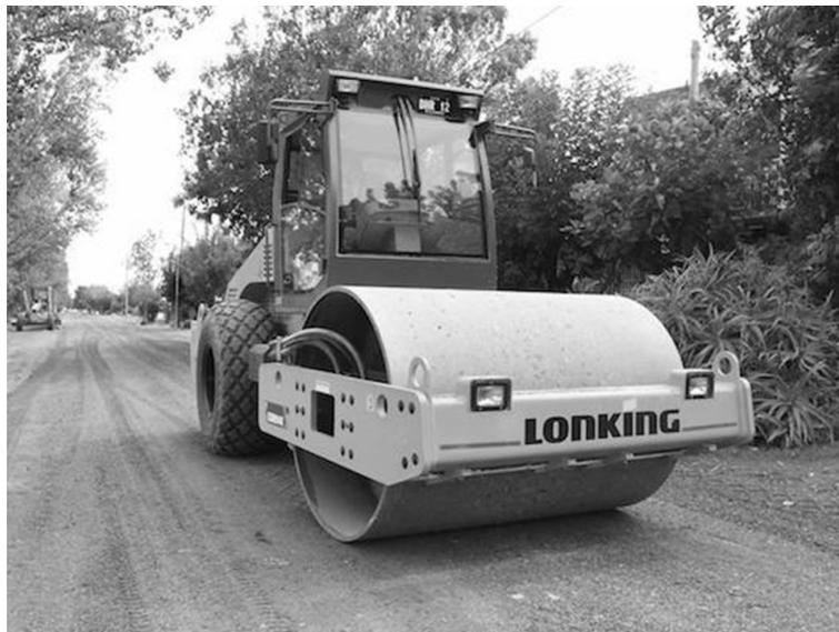
*Figura 24.1. Capas de rodamiento 100 % de RAP*
