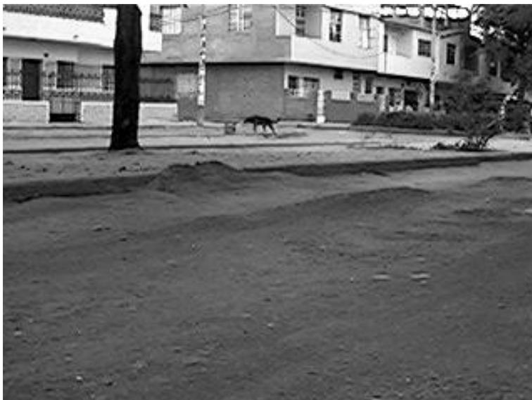
*Figura 6.2. Pavimento ahuellado*
