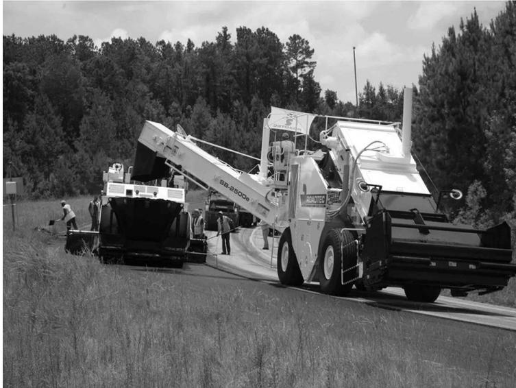
*Figura 9.7. Empleo de un vehículo de transferencia de la mezcla asfáltica*
