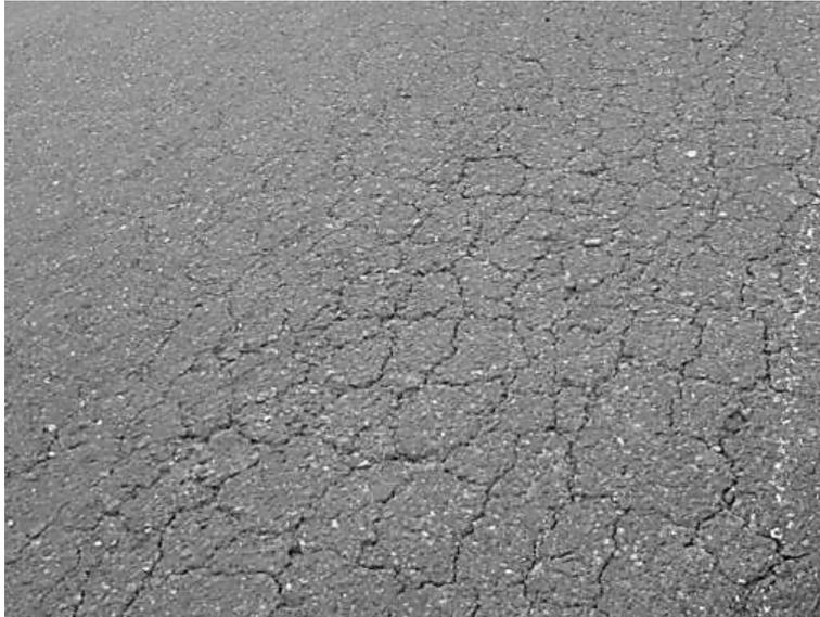
*Figura 6.1. Fisura tipo piel de cocodrilo*
