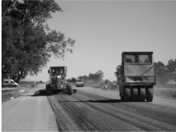
*Figura 25.1. Construcción de una capa de estabilizado granulométrico*
