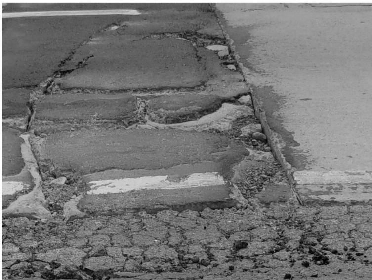
*Figura 18.2. Resultado final de mala aplicación de mezcla asfáltica sobre pavimentos de hormigón*
