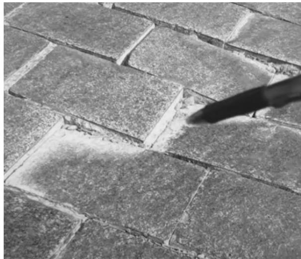
Figura 23.3. Deformación prematura por adoquines perfectamente prismáticos
