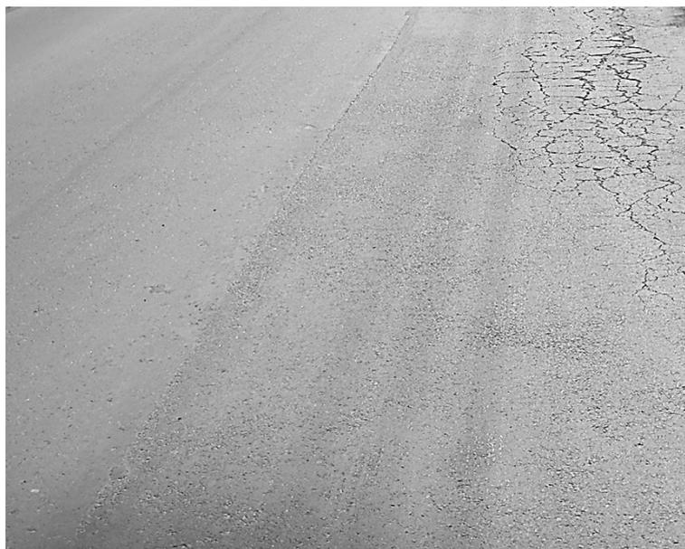
*Figura 14.2. Falla localizada prematura de un pavimento asfáltico*
