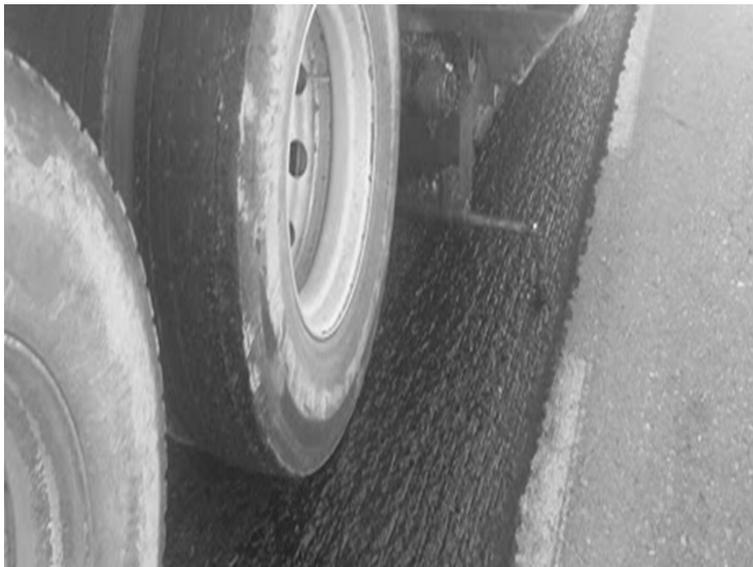
*Figura 9.8. Riego de liga mediante una emulsión asfáltica termoadherente*
