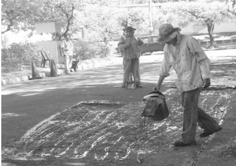
*Figura 18.1. Aplicación inadecuada de un riego de liga en recapados*
