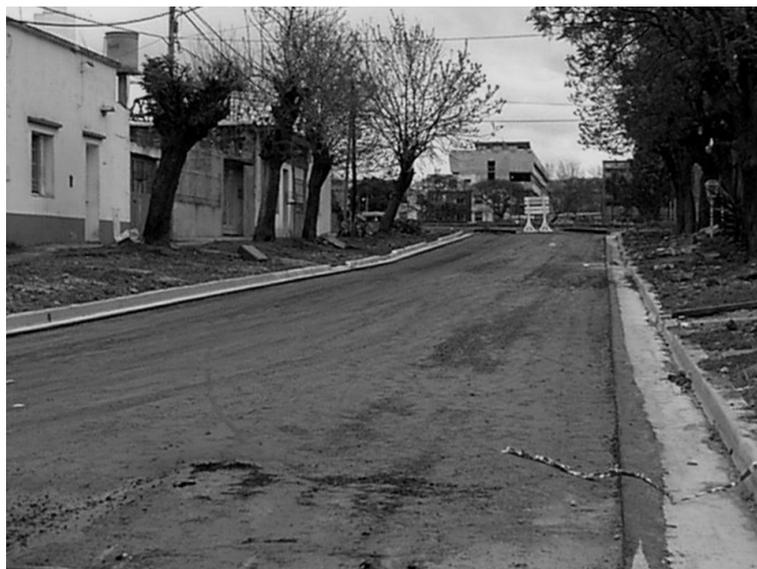
*Figura 9.3. Deposición excesiva de riego por detención del regador*
