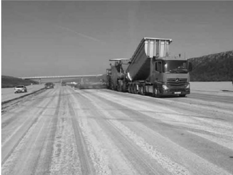
*Figura 9.10. Empleo de una lechada de cal sobre el riego de liga*
