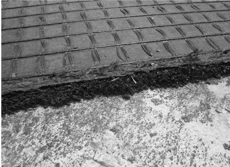
*Figura 18.3. Interposición de capa asfáltica de nivelación más geosintético*
