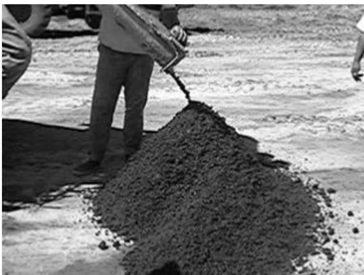
*Figura 17.1. Elaboración artesanal de concreto asfáltico en frío almacenable*
