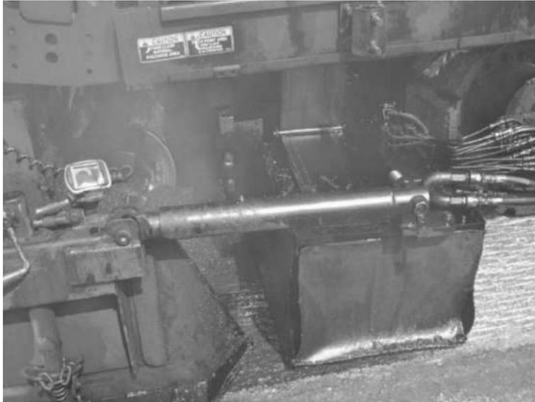
*Figura 9.9. Aplicación del riego de liga junto con el extendido de la mezcla asfáltica*
