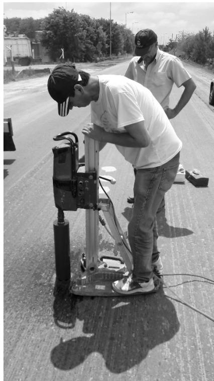
*Figura 14.1. Extracción de testigo de carpeta asfáltica (Rivera, 2019)*
