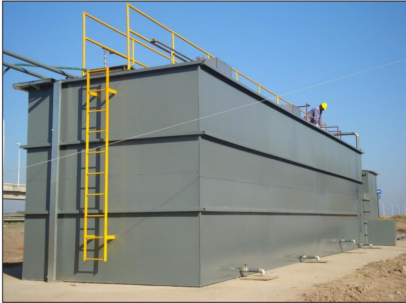
Figura 8.2: Planta de tratamiento de efluentes modular. (Fuente: Bioingepro, 2022)
