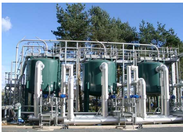
Ilustración 10.6-1: Sistema de depuración del aire contaminado con compuestos orgánicos volátiles. Fuente: https://www.interempresas.net/Reciclaje/Articulos/25979-Emission-de-compuestos-organicos-volatiles-tecnicas-de-depuracion.html
