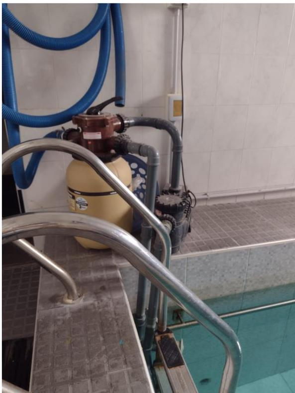
**Imagen 3.** Bombas para filtrado y lavado de pileta ubicada junto a la misma
