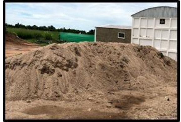
Figura 3: Acopio arena gruesa
