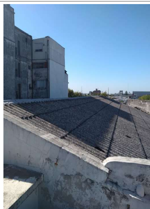
c.1.1) Detalle chapa de fibrocemento en cubierta ala derecha.
