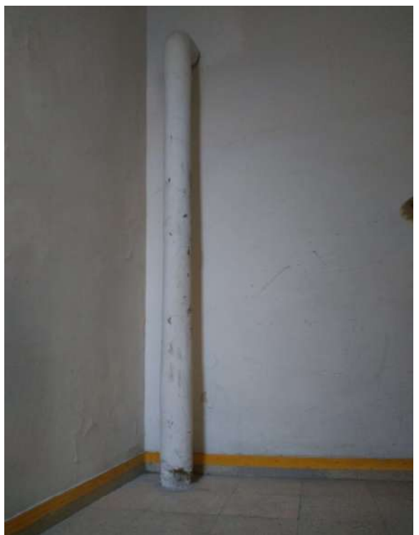
Detalle material aislante de cañería en descanso de escalera.
