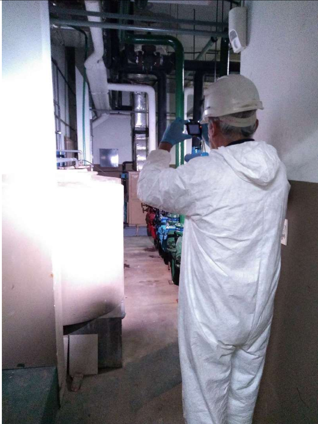
Vista fotográfica 1: Recinto sala de máquinas. Al fondo se encuentra la caldera y cañerías. Al frente, operario encargado del retiro de las muestras de este sector.
