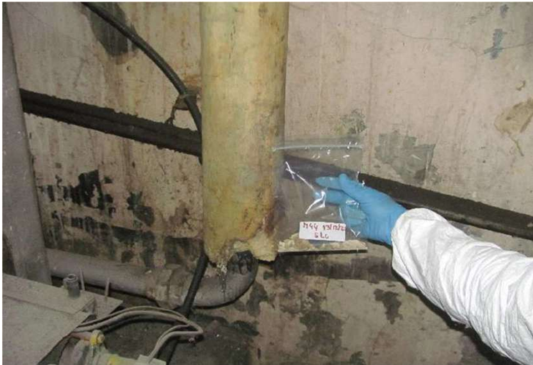
Detalle de toma de muestra de bajada de cañería. Similar para el resto.
