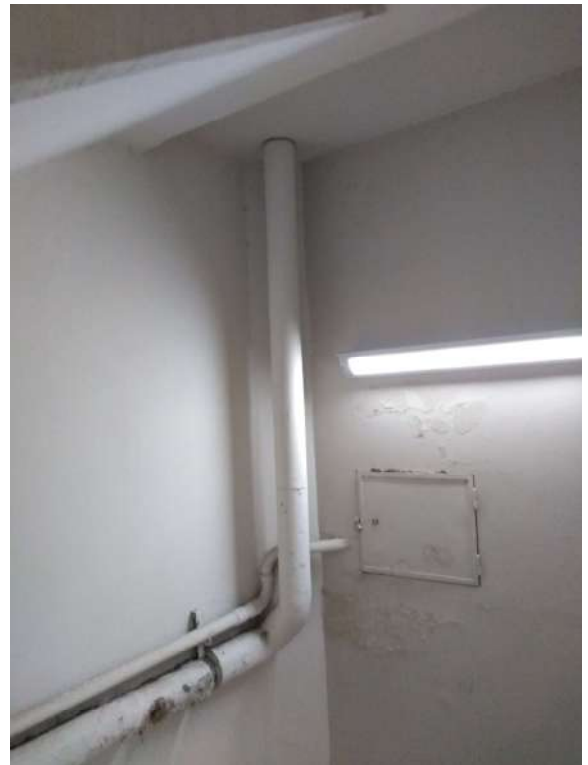
Detalle de subida a descanso de escalera superior.
