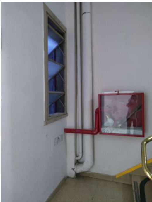
Detalle de ventana en zona de cañerías.
