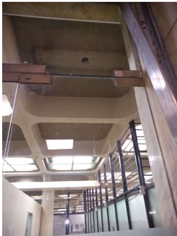
a.1) Detalle del sector. Vista de bajo techo con casetonado.
