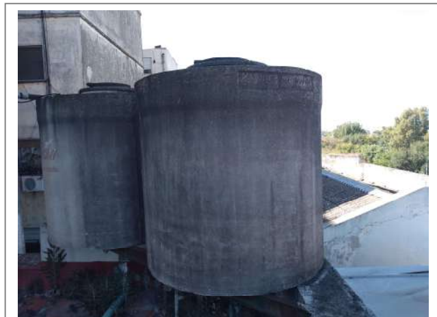
c.1.2) Detalle reverso tanques de fibrocemento
