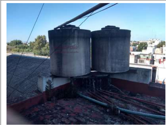
c.1.2) Detalle general de tanques fibrocemento.
