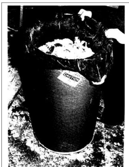
Contenedor de cartón forrado en bolsa plástica con residuos de asbestos (foto EPA 530/85-07, Mayo 1985).
