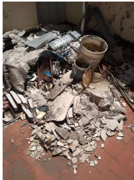
c.1.3) Residuos de fibrocemento en terraza
