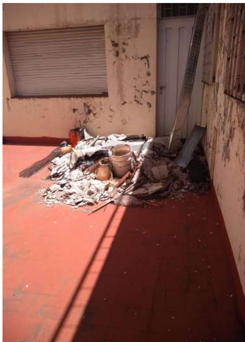
c.1.3) Residuos de fibrocemento en terraza
